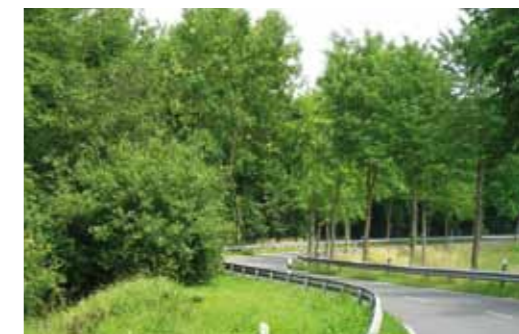
➤ Fehlender Unterfahrschutz kann Leben kosten
