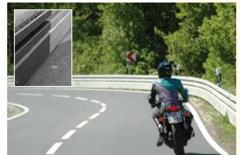
➤ Seitenraum der kurvigen Strecke mit Unterfahrschutz an Schutzplancken abgesichert mit System „Euskirchen Plus“
