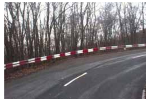
➤ Gute optische Führung – lebensrettender Unterfahrschutz fehlt jedoch
