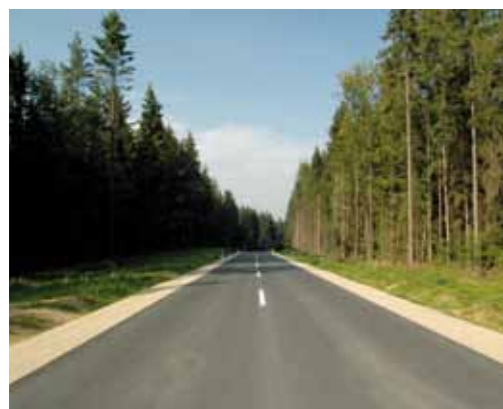
➤ Ein gehärtetes Straßenbankett zwischen Fahrbahn und Böschungsmulde schafft einen Puffer zu seitlichen Hindernissen
