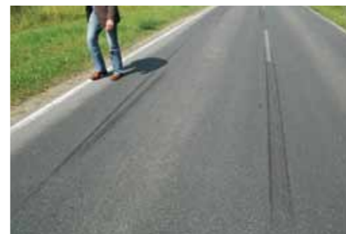
➤ Spurrillen und Bitumenauftrieb (glattpolierte Flächen!) machen sicher erscheinende Straßen zur tödlichen Falle
