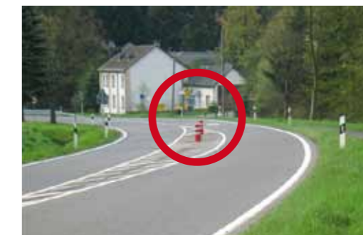
> Nachher: Entfernen der Verkehrszeichen und Ersetzen durch flexible, rot-weiß-reflektierende Poller
