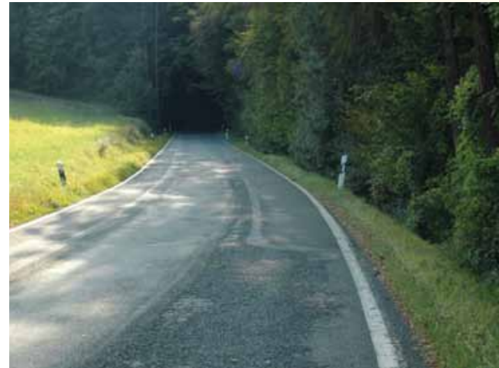
➤ Flickenteppiche bergen für Motorradfahrer bei Nässe große Gefahren
