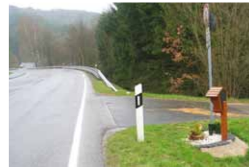
> Vorher: Kritische Zufahrt hinter einer Kurve
