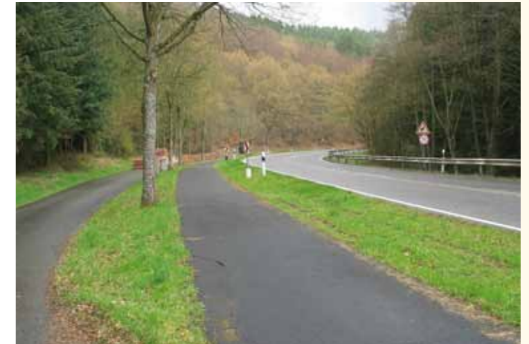
➤ Vorher: Langgezogene Kurve mit Bäumen und Richtungstafeln auf Stahlpfosten als Hindernisse im Seitenraum
