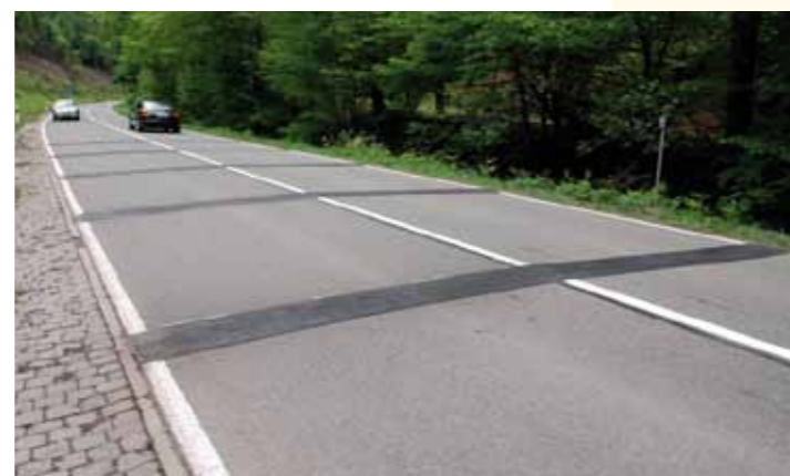
➤ Quer- bzw. Rüttelstreifen (ca. 1,5 cm hohe und 50 cm breite Asphaltstreifen!) reduzieren wirksam die Geschwindigkeit
