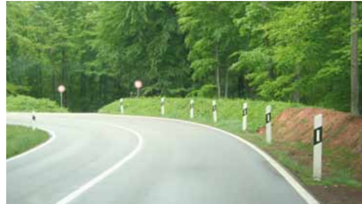
➤ Minderung des Unfallrisikos auf der kritischen Passage durch Aufschüttung eines Erdwalls im Seitenraum
