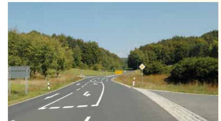
> Vorbildliche Aufstellmöglichkeit für Linksabbieger an einer kritischen Zufahrt
