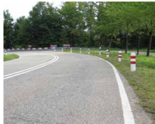
> Balisette-Versuchsstrecke auf Schwarzwald-Hochstraße
