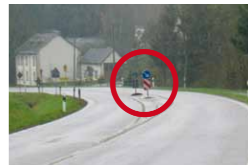
> Vorher: Fahrbahnteiler mit Verkehrszeichen auf Stahlpfosten
