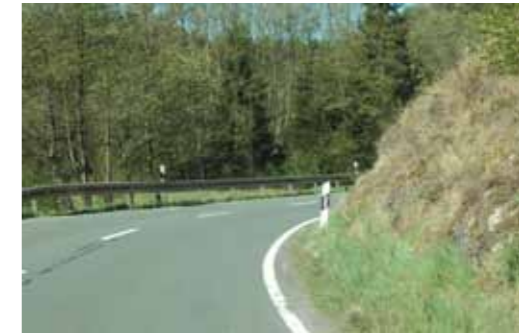
➤ Unzulängliche Sichtweite – kein Unterfahrschutz
