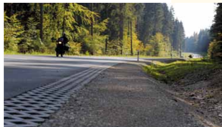
➤ Ein gehärtetes Straßenbankett zwischen Fahrbahn und Böschungsmulde schafft einen Puffer zu seitlichen Hindernissen
