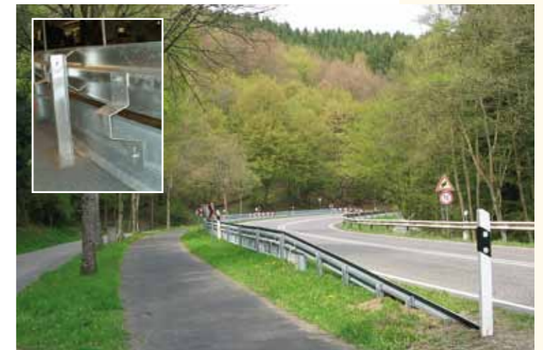
➤ Nachher: Neue Schutzplancke mit Unterfahrschutz gegen Anprall an Hindernisse und zum Schutz von Radfahrern und Fußgängern
