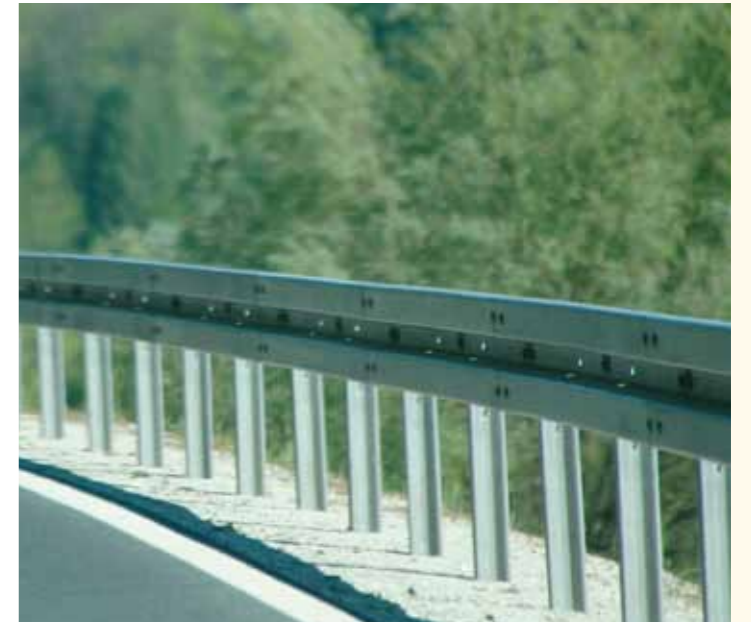
➤ Für Autofahrer ungefährlich, für Motorradfahrer eine tödliche Falle: Schutzplankenpfosten
