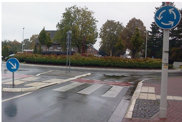
Differenzierte Bordhöhen am Zebrastreifen und Radfahrerfurt
