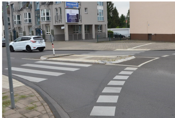
Zu geringer Abstand zwischen Überquerungsstelle und Kreisfahrbahn
