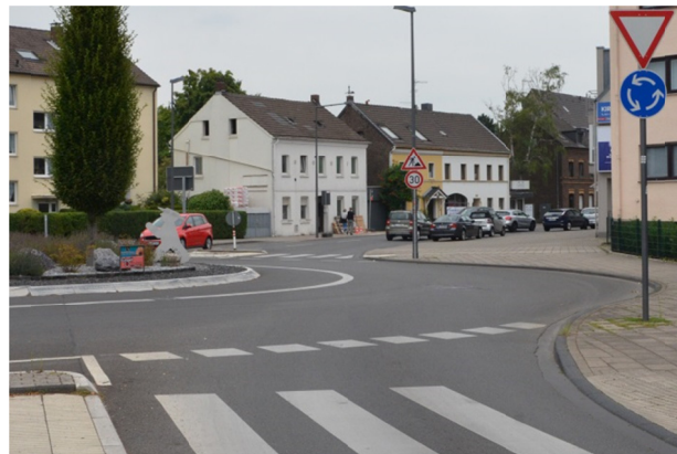
„Durchschuss-Wirkung“ durch geringes Ablenkmaß der Kreisinsel
