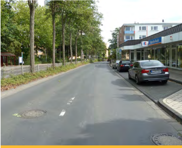
Vorher: Überquerungsstellen für zu Fuß Gehende sind nur in großen Abständen und teilweise als Unterführungen vorhanden, Radverkehrsanlagen fehlen gänzlich. Fotos: Stadt Baunatal, Abteilung Tiefbau und Tiefbauunterhaltung
