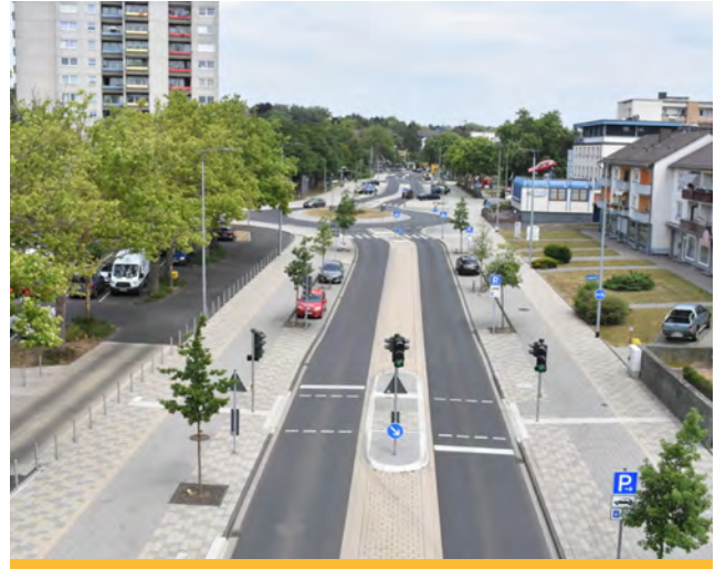
Nachher: breite Seitenräume mit Radwegen zwischen Multifunktionsstreifen und Gehflächen sowie durch einen überfahrbaren Mittelstreifen getrennte einstreifige Richtungsfahrbahnen.
