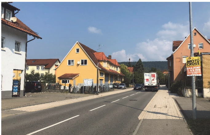
Bilder 28 und 29 | Gestaltungsgrundsatz Trennungsprinzip: die Fahrbahn lässt Begegnungen im Schwerverkehr bei der angeordneten Geschwindigkeit von 30 km/h uneingeschränkt zu, die unterbrochene Leitlinie (linkes Bild) endet vor der ersten gepflasterten Einmündung und wird dahinter (rechtes Bild) nicht weitergeführt
