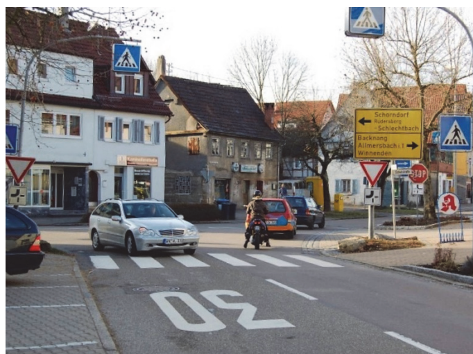
Bilder 3 und 4 | Vorher-Situation in Ortsmitte: Die überdimensionierte Fahrbahn, in Teilabschnitten beidseitig angeordnetes Parken und eine Vielfalt von Verkehrszeichen, Markierungen, Wegweisungsschildern dominieren das Straßenbild, freies Überqueren ist gefährlich, Zufußgehende sind an den Rand gedrängt, Aufenthaltsnutzungen finden kaum Platz
