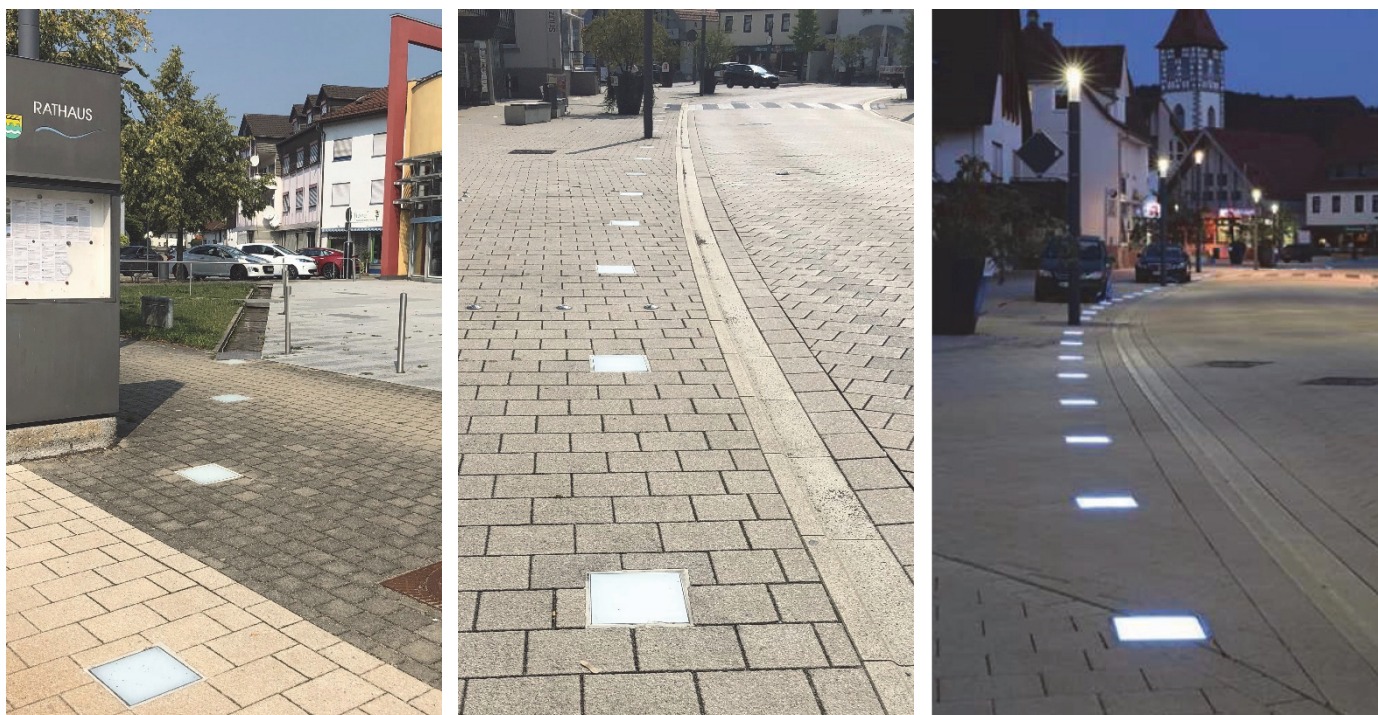
Bilder 42 bis 44 | Lichtkonzept in Ortsmitte: blaue LED-Bodenleuchten stellen den ehemaligen Lauf des Glasofenbachs nach; im Nachtbild wird die abgestimmte Konzeption von Bodenleuchten und Straßenraumbeleuchtung gut erkennbar
