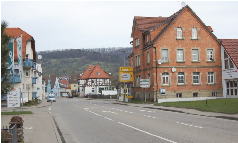
Bild 5 | Vorher-Situation in der südlichen Ortsdurchfahrt: Die Aufweitung der Fahrbahn durch zusätzliche Linksabbiegestreifen lässt nur noch schmale Gehwege zu und verstärkt den Charakter einer „Durchfahrtsstraße“
