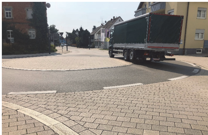
Bilder 32 und 33 | Zentraler Knotenpunkt der Ortsdurchfahrten: die gewählte Ausbauf orm als Minikreisverkehr spart wertvolle Flächen und weist trotz hoher Kfz- und Schwerverkehrsbelastung kein Leistungsfähigkeitsdefizit auf
