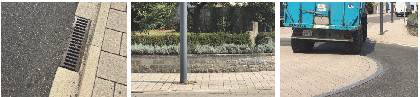
Bilder 39 bis 41 | Oberflächenmaterialien im Abschnitt südlich der Ortsmitte: Asphaltfahrbahn mit schmalen und niedrigem Sonderbord mit integrierten Abläufen (links), Nullabsenkungen im Bereich von in der Fahrbahn gepflasterten Überquerungsstellen (Mitte), stabile Einfassung der überfahrbaren Kreisinsel des Minikreisverkehrs durch einen anthrazitfarbenen, nur leicht angeschrägten Bordstein (rechts)
