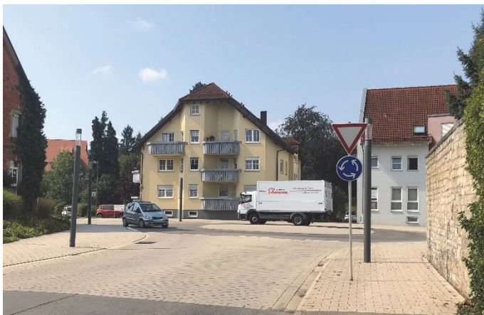
Bilder 32 und 33 | Zentraler Knotenpunkt der Ortsdurchfahrten: die gewählte Ausbauf orm als Minikreisverkehr spart wertvolle Flächen und weist trotz hoher Kfz- und Schwerverkehrsbelastung kein Leistungsfähigkeitsdefizit auf
