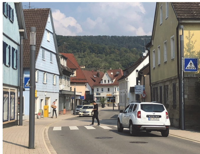
Bilder 30 und 31 | Seitenraum: wechselnde Baufluchtabstände führen zu unterschiedlichen Gehwegbreiten, die jedoch an keiner Stelle das Mindestmaß nach Regelwerk unterschreiten, die gepflasterte „Gehwegüberfahrt“ (linker Gehweg im rechten Bild) betont den Vorrang für Zufußgehende über die Einmündung der Seitenstraße hinweg, der Fußgängerüberweg betont zugleich den Beginn der Ortsmitte
