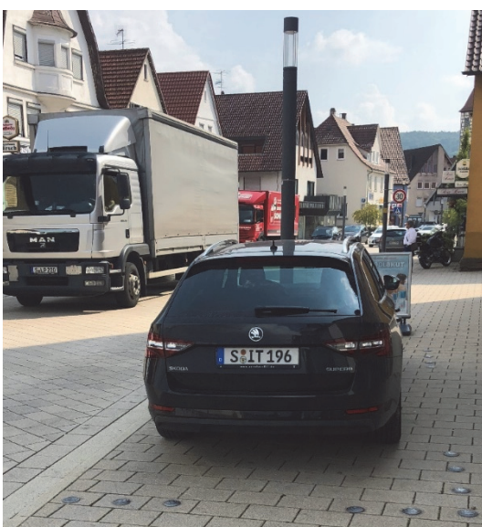
Bilder 19 und 20 | Parken und Liefern: nur durch Markierungsnägel aus Aluminium vom übrigen Seitenraum abgegrenzte Parkstände, ausreichend breit für SUV und andere große Pkw sowie Lieferwagen und Lkw bis 3,5 t
