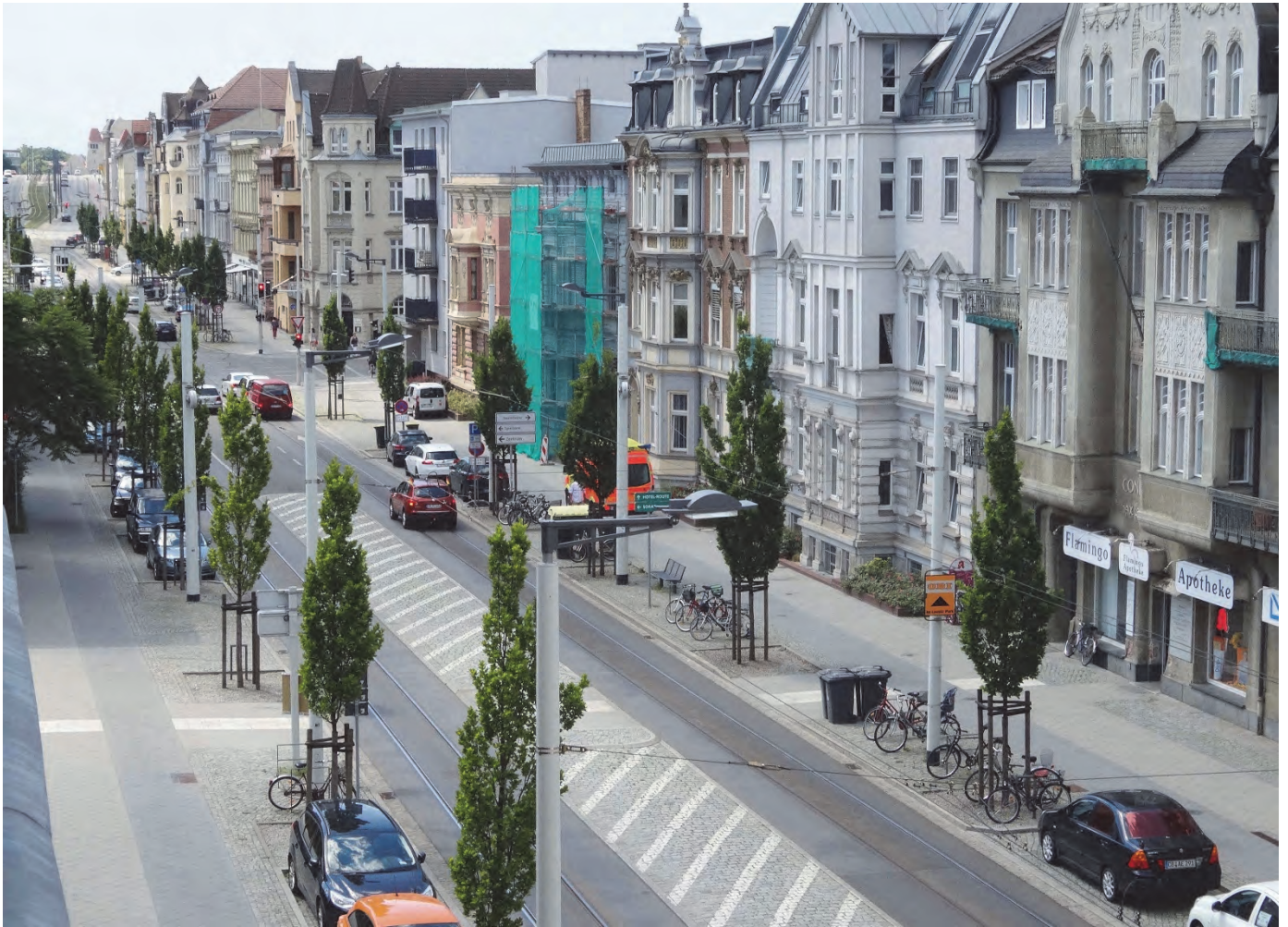
Bild 1 | Die Bahnhofstraße nach dem Umbau: differenzierte Querschnittgestaltung mit dem Ziel der Gleichberechtigung für alle Verkehrsarten
