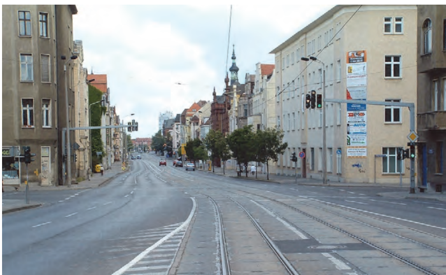
Bilder 3 und 4 | Vorher-Situation: Überdimensionierte Fahrbahn mit überwiegend vier Fahrstreifen, straßenbündigem Bahnkörper, ohne Anlagen für den Radverkehr, nicht barrierefrei, mit wenigen Grünelementen und geringer Aufenthaltsqualität
