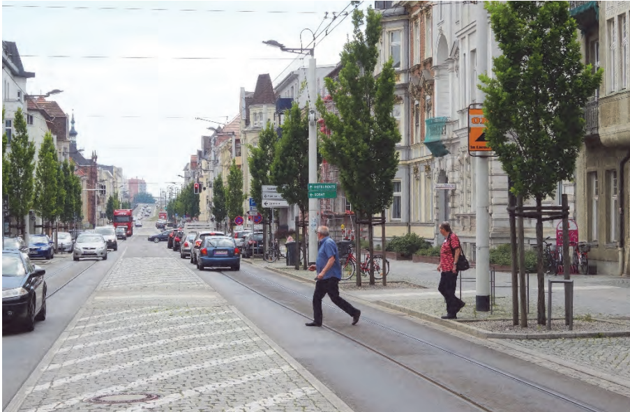
Bild 15 | Gliederungselement Mittelstreifen: Natursteinpflaster in Kleinformat auf Fahrbahnniveau, eingefasst durch Rundborde und mit 3,25 m Breite gut geeignet zur freien Überquerung der Fahrbahn in Streckenabschnitten, an ausgewählten Stellen sind schwach ausgeprägt gestaltete „Mittelseln“ mit abgesenkten Borden und Leiteinrichtungen für Sehbeeinträchtigte eingelagert
