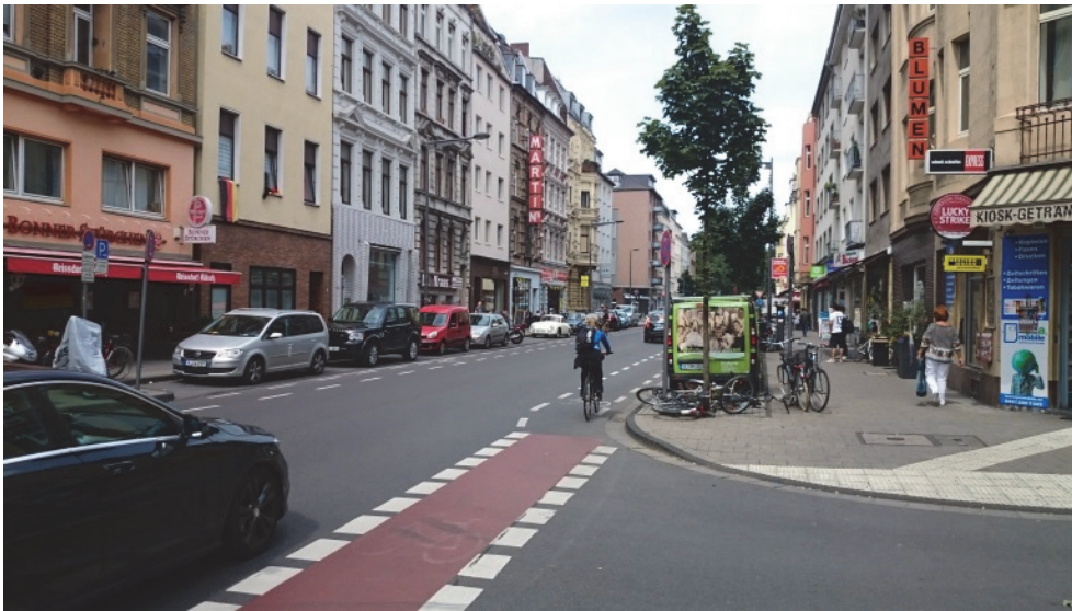
Bild 10 | Schärfung der Wahrnehmung: Nur an Stellen mit besonderem Gefährdungspotenzial (Einmündungen, Tankstellenzufahrt u. ä.) ist der Schutzstreifen rot eingefärbt, um die Aufmerksamkeit der Kraftfahrenden zu erhöhen
