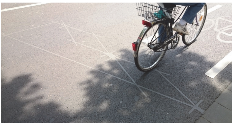
Bild 24 | Dauerzählstelle im Radverkehr: Induktionsschleifen in der Fahrbahn mit witterungs- und vandalismusgeschützt in den Boden eingelassenem Modem im Seitenraum (hier nicht sichtbar)
