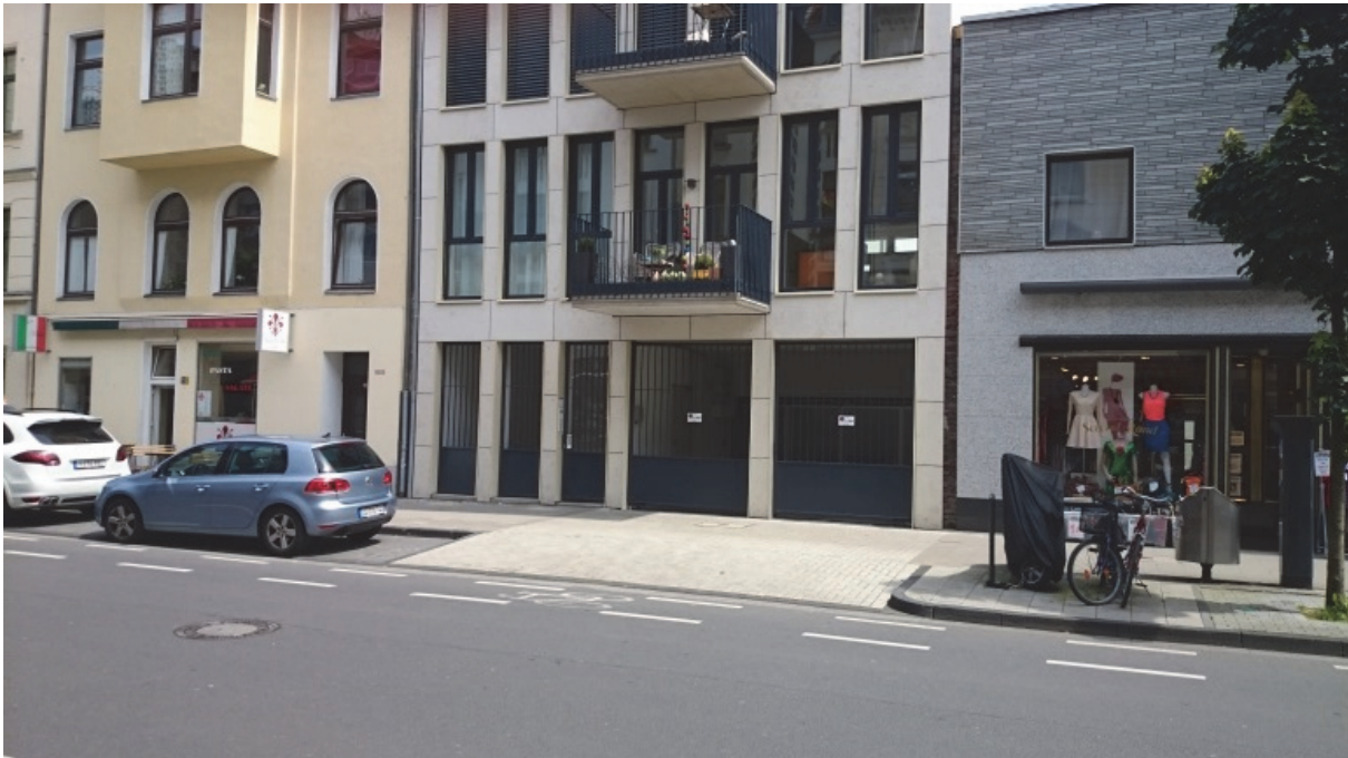
Bild 14 | Komfortaspekt für Zufußgehende: Anrampungen in Grundstückszufahrten liegen außerhalb der eigentlichen Gehflächen
