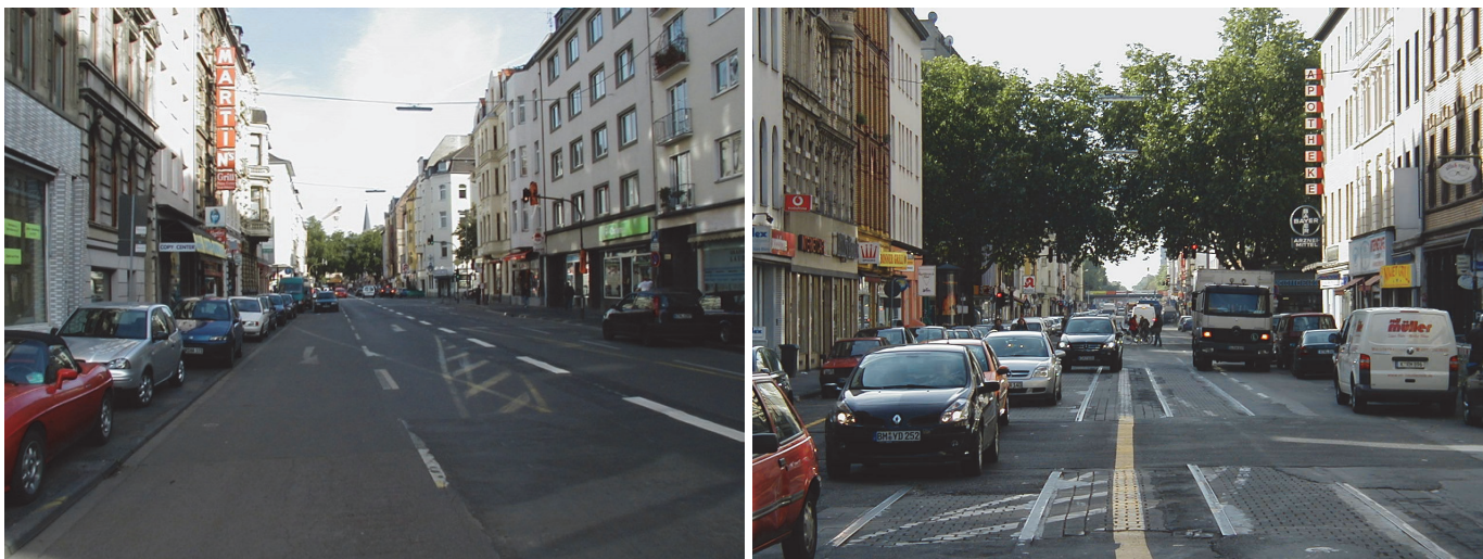
Bilder 3 und 4 | Vorher-Situation: Überdimensionierte Fahrbahn mit ungeordneter Nutzung durch den Kfz-Verkehr zulasten von Zufußgehenden, Radfahrenden und Aufenthalt sowie durch Wegfall der Straßenbahn und Fertigstellung der U-Bahn notwendig gewordene Oberflächensanierung
