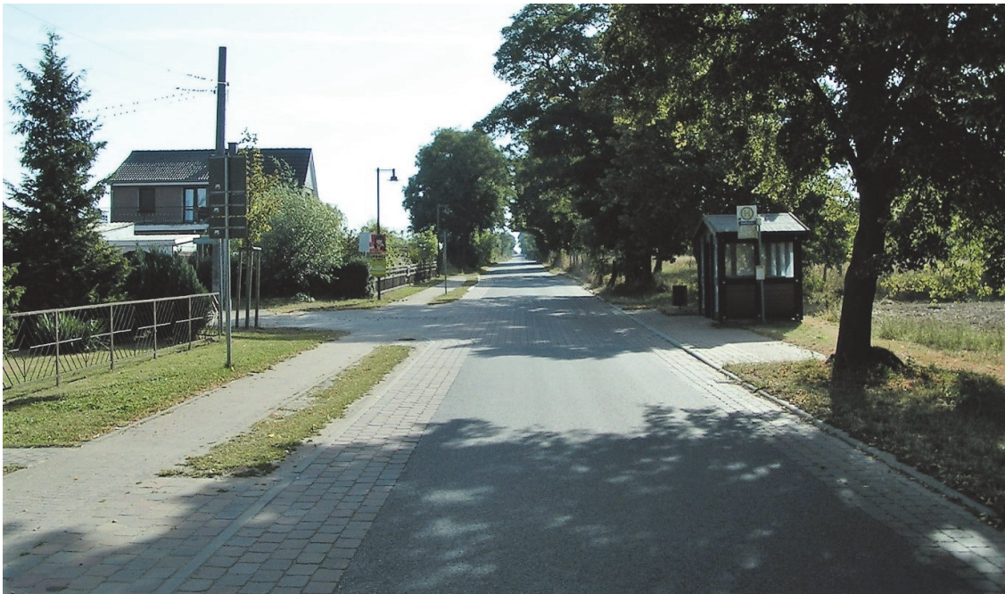
Bild 23 | Bushaltestelle „Meseberg Dorfstraße“: funktionale Mindestausstattung, Haltestellenschild mit Fahrplaninformationen, einseitiger Witterungsschutz, befestigter Bereich zum Warten, Ein- und Aussteigen und nahe gelegene Beleuchtung zur Erhöhung der sozialen Sicherheit bei Dunkelheit
