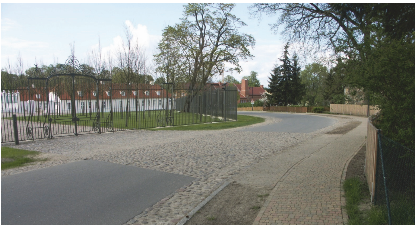
Bild 15 | Belagswechsel im Zuge der Ortsdurchfahrt: Pflasterflächen aus großformatigem Kopfsteinpflaster markieren beispielsweise den Zugangsbereich zum Schloss Meseberg mit verstärktem Überquerungsbedarf von Zufußgehenden oder auch Einmündungsbereiche von Nebenstraßen und Zufahrten zu privaten Grundstücken
