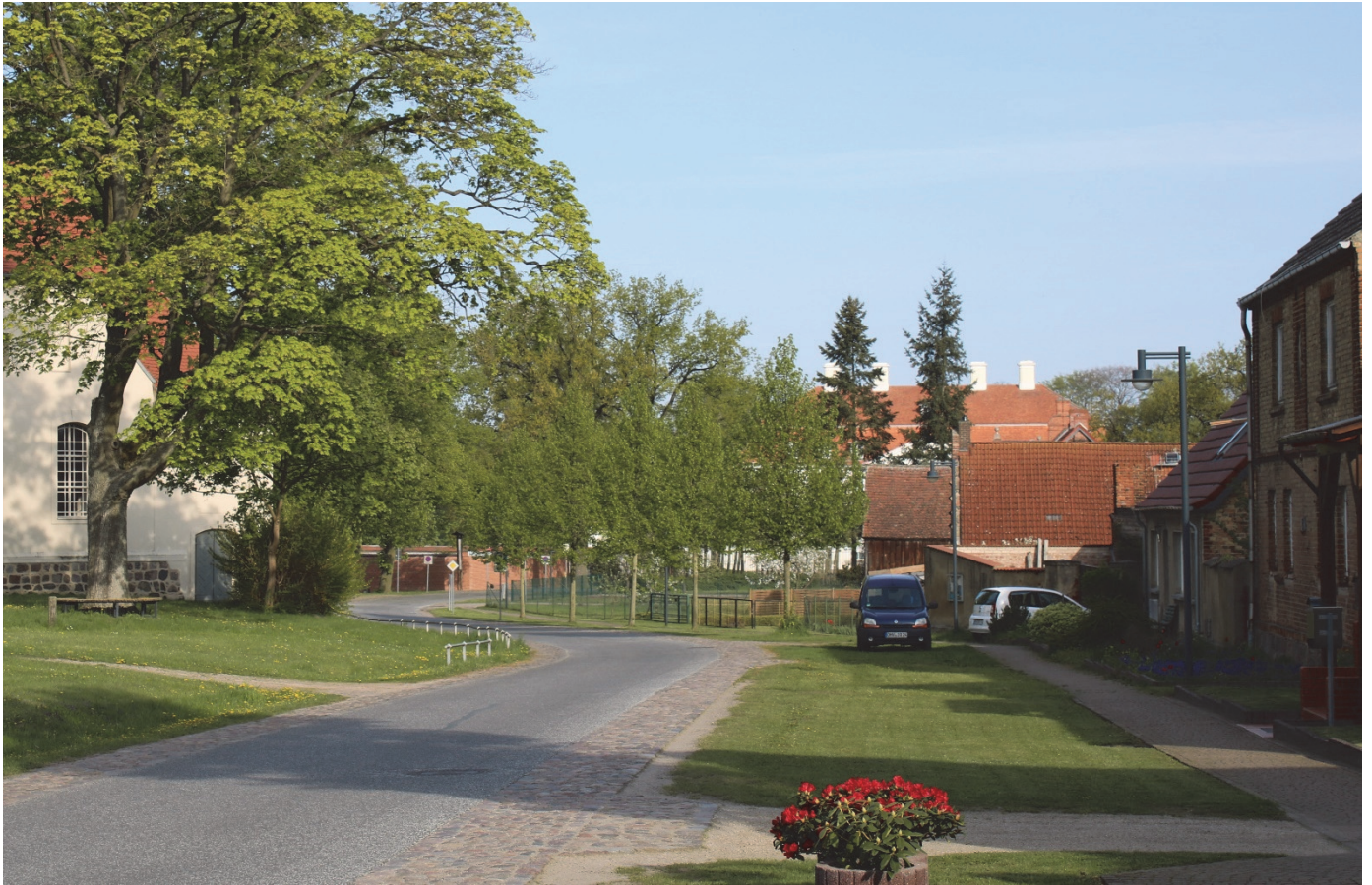
Bild 1 | Die Dorfstraße nach dem Umbau: dem Dorfgrundriss und Verkehrsaufkommen angepasste Linienführung und Dimensionierung der Geh- und Fahrflächen, durch Versickerungsmulden abgesetzt
