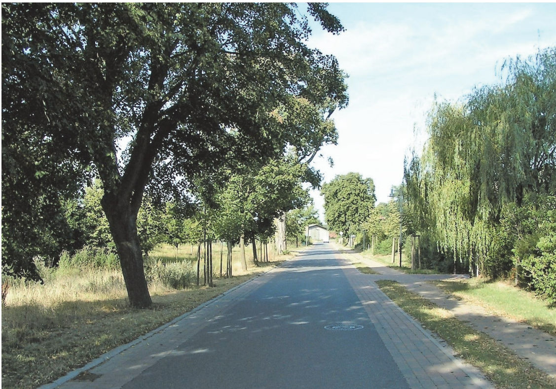
Bild 13 | Östlicher Abschnitt: schmale Asphaltfahrbahn mit beidseitig mehrzeiligen Betonsteinpflasterstreifen und einseitig begleitendem Gehweg, der durch einen schmalen Grünstreifen abgesetzt ist und auf der Siedlungsseite (Neubaugebiet nördlich der Dorfstraße, im Bild rechts durch den Baumbestand verdeckt) verläuft; im Hintergrund die Rechtskurve, hinter der der zentrale Angerbereich beginnt
