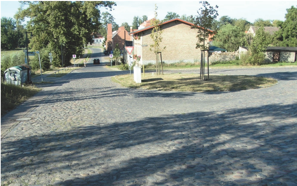
Bild 8 | Westlicher Ortseingangsbereich: platzähnlich aufgeweitete Fläche mit abknickender Vorfahrt und flächigem Pflasterbelag aus großformatigem Naturstein, gleichzeitig für die Nutzung als Buswendeschleife dimensioniert
