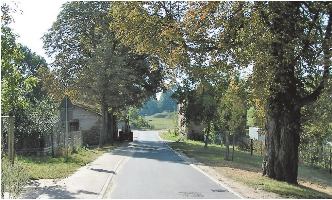
Bild 7 | Westliche Ortszufahrt: schmale Asphaltfahrbahn von 3,50 m Breite und einseitig 1,50 m breiter, im seltenen Kfz-Begegnungsfall überfahrbarer Gehweg
