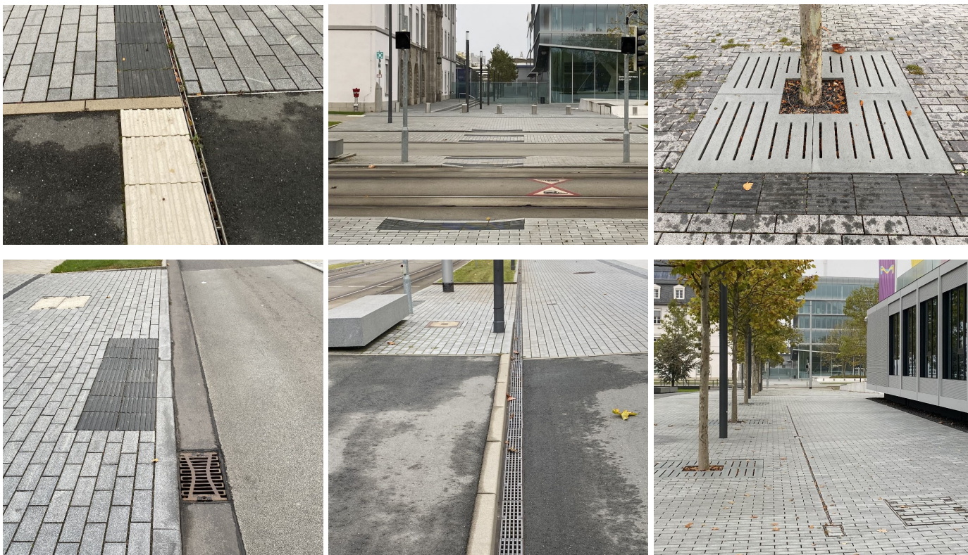
Bilder 34 bis 39 | Weitere bautechnische Details: Farbwahl der Bodenindikatoren abhängig vom Oberflächenbelag (oben links), Bordabsenkung im Zuge der Fahrbahn- und Gleisquerungen (oben Mitte), übergebares Baumrost (oben rechts), Oberflächenentwässerung mittels Straßenabläufen (unten links), Kastenrinnen (unten Mitte) oder Schlitzrinnen (unten rechts)
