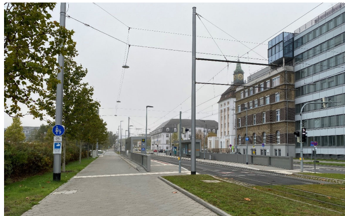
Bilder 14 und 15 | Führung des Fuß- und Radverkehrs: in Bild 14 erkennbar mindestens 4,50 m breiter, gemeinsam genutzte Verkehrsfläche für Zufußgehende und Radfahrende; abweichend von der Beschilderung als „Gemeinsamer Geh- und Radweg“ gilt parallel zur Straßenbahnhaltestelle für aus nördlicher Richtung kommende Radfahrende „Gehweg, Radfahrer frei“ (Bild 15)
