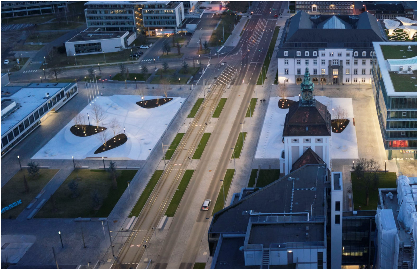
Bild 1 | Der Emanuel-Merck-Platz nach dem Umbau: gestalterische Integration des Verkehrsraums der Frankfurter Straße in die beiderseits liegenden Platzbereiche mit Auflösung der Kfz-Fahrbahn in zwei Richtungsfahrbahnen und Realisierung von linear wirksamen Elementen zur Sicherung der Überquerbarkeit und des Zugangs zur Straßenbahnhaltstelle
