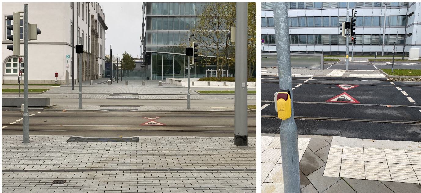
Bilder 23 und 24 | Querungsangebot: Dunkelampeln zeigen Gelbblinken bei Herannahen der Bahn, Rampen mit Bordabsenkung auf Null ermöglichen die barrierefreie Nutzung der Querungsstellen mit Rollstuhl und Rollator, Bodenindikatoren wurden zwecks besserer Erkennbarkeit für Sehbeeinträchtigte farblich konträr zum Oberflächenbelag gewählt – hier anthrazit auf hellgrau, weiß auf dunkelgrau (Lage siehe Bild 18, links Nr. 1, rechts Nr. 5)
