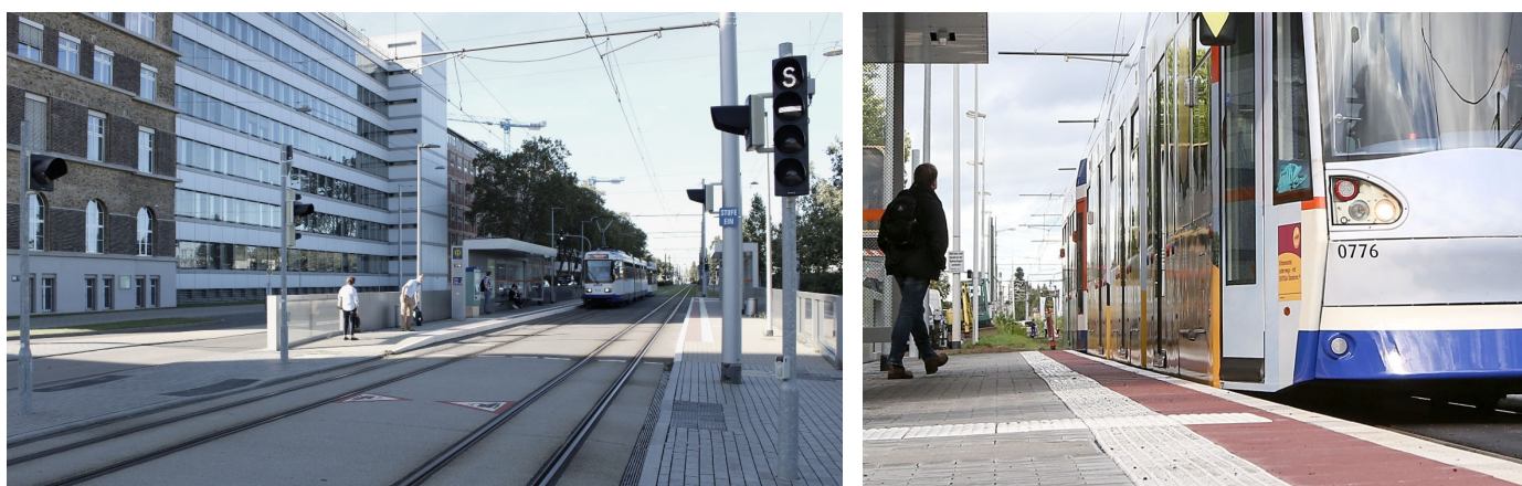
Bilder 25 und 26 | Neue Straßenbahnhaltestelle „Merck“: auf 3,75 m verbreiterte Bahnsteige unmittelbar nördlich des Emanuel-Merck-Platzes (linkes Bild) mit gesicherten Zugängen an beiden Bahnsteigenden, Bodenindikatoren für Sehbeeinträchtigte, rot eingefärbten Ein- und Ausstiegsflächen und barrierefreier Einstiegshöhe (rechtes Bild)
