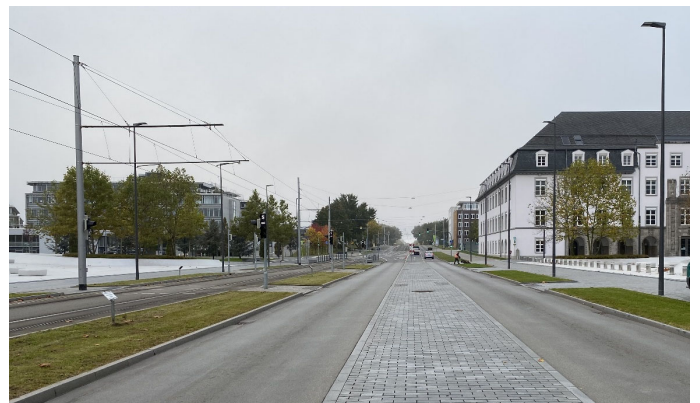
Bilder 8 und 9 | Fahrbahn im Platzbereich: einstreifige, in den Einfahrtbereichen geringfügig angerampfte Richtungsfahrbahnen mit übergehbarem Mittelstreifen sowie teils begehbaren, teils begrünten Trennstreifen zu den parallel verlaufenden Verkehrsflächen von Straßenbahn, Rad- und Fußverkehr
