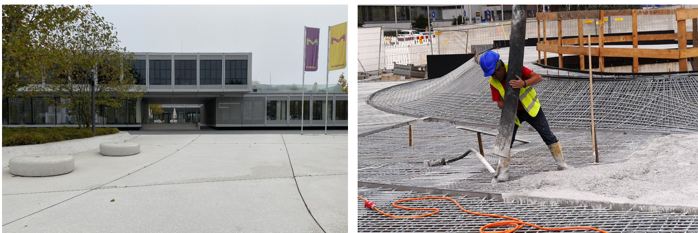
Bilder 40 und 41 | Bauausführung Platzfläche: Schlitzrinnen-Sonderkonstruktion zur Oberflächenentwässerung (links erkennbar), einschichtig von Hand eingebauter Weißbeton, hergestellt nach eigens für diese Anwendung entwickelter Rezeptur
