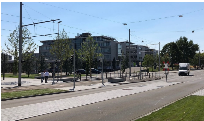
Bilder 8 und 9 | Fahrbahn im Platzbereich: einstreifige, in den Einfahrtbereichen geringfügig angerampfte Richtungsfahrbahnen mit übergehbarem Mittelstreifen sowie teils begehbaren, teils begrünten Trennstreifen zu den parallel verlaufenden Verkehrsflächen von Straßenbahn, Rad- und Fußverkehr
