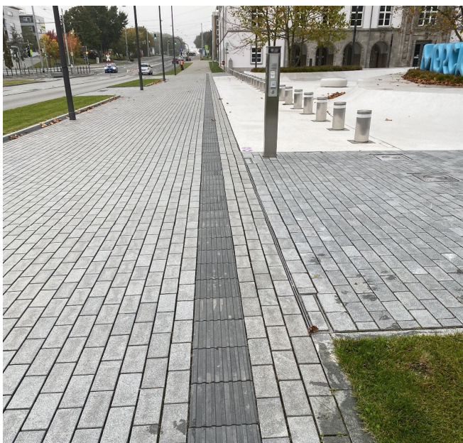
Bild 33 | Elemente zur Führung und Abgrenzung: unterschiedlich gefärbte und strukturierte Oberflächenmaterialien, unterstützt durch Bodenindikatoren als „innere Leitlinie“ für Sehbeeinträchtigte und – teils versenkbare – Poller aus Edelstahl
