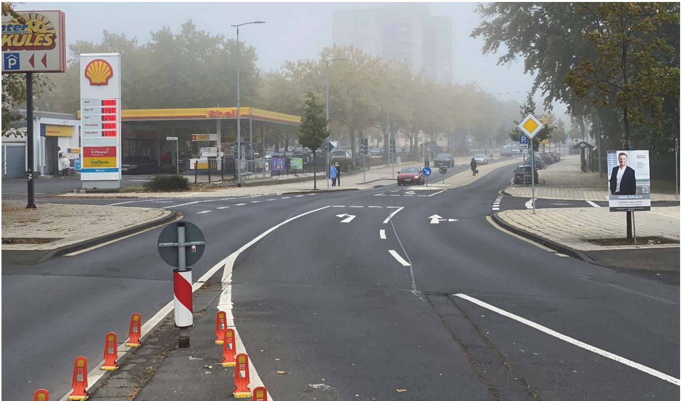
Bild 28 | Radverkehrsführung im Übergang zum Bestand: Aufnahme des Radverkehrs innerhalb der komplett in die Umgestaltung einbezogenen Kreuzung Kirchbaunaer Straße / Marktstraße / Im Wiesental
