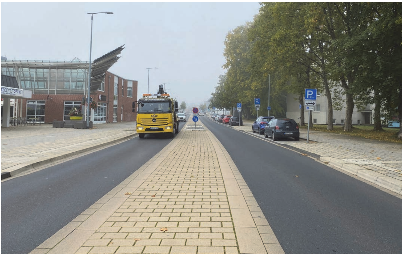
Bild 12 | Realisierter Fahrbahnquerschnitt: einstreifige Richtungsfahrbahnen in 3,25 m Regelbreite, durch einen niveaugleich gepflasterten Mittelstreifen getrennt, der überfahren und von Zufußgehenden zum Überqueren der Fahrbahn in zwei Zügen genutzt werden und bei der gegebenen Breite von 2,50 m auch bauliche Fahrbahnteiler und Mittelinseln als gesicherte Querungsstellen – hinten im Bild – gut aufnehmen kann
