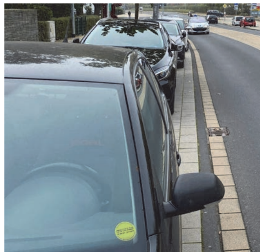
Bilder 46 bis 48 | Parkstände im Straßenraum: überwiegend Längsaufstellung (oben links), bei breiteren Baufluchtabständen auch Schrägaufstellung (oben rechts), die gewählte Breite von 2,25 m begünstigt offenbar ein geordnetes Abstellen der Fahrzeuge (rechts)
