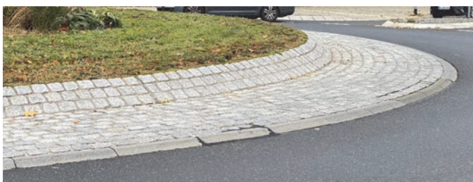
Bilder 21 und 22 | Gestaltungsdetails: die Mitnutzung des gepflasterten Innenkreises durch Schwerverkehrsfahrzeuge führt auf Dauer zu sichtbaren Nutzungsspuren und Bauschäden (links unten), auch im Kreis lässt sich ein Grundstück gut anschließen (rechts), wenn die Übersichtlichkeit der Gesamtsituation gegeben ist und geringe Geschwindigkeiten gefahren werden
