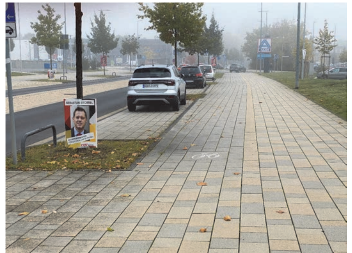
Bilder 26 und 27 | Radverkehrsführung im Übergang zum Bestand: aus Westen kommend zunächst gemeinsamer Geh- und Radweg (links), im Zulauf zum zentralen Kreisverkehrsplatz dann Trennung von Rad- und Gehweg mit Piktogramm-Platte (rechts)
