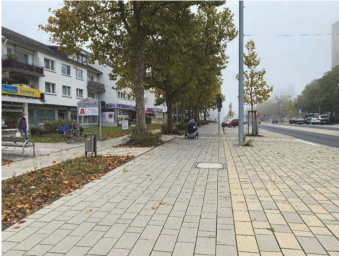
Bilder 24 und 25 | Radverkehrsanlagen: durchgängige Herstellung von 2 m breiten Radwegen im Seitenraum, neben Parkstreifen (rechtes Bild) sind darin 0,75 m als Sicherheitstrennstreifen enthalten, in Abschnitten ohne Parkstreifen (linkes Bild) verlaufen die Radwege von der Fahrbahn abgesetzt und ergeben damit Multifunktionsflächen für unterschiedliche Nutzungen
