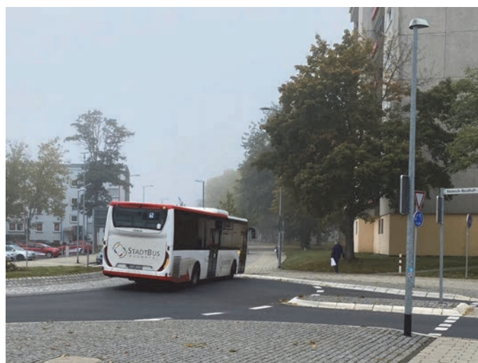
Bilder 19 bis 20 | Nutzungsdetails: im Alltag zeigt sich eine gute Befahrbarkeit und ein flüssiger Verkehrsablauf (links), auch der Stadtbus kann den Kreisverkehr offenbar ohne Mitnutzung des gepflasterten Innenkreises befahren (rechts)
