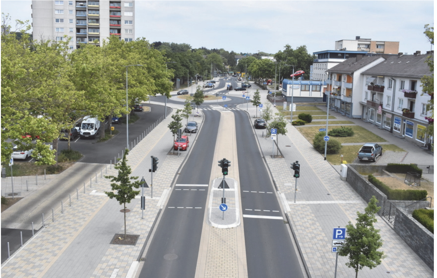
Bild 1 | Die Kirchbaunaer Straße nach dem Umbau: breite Seitenräume mit Radwegen zwischen Multifunktionsstreifen und Gehflächen sowie durch einen überfahrbaren Mittelstreifen getrennte einstreifige Richtungsfahrbahnen; Heinrich-Nordhoff-Straße (hinten im Bild) und Friedrich-Ebert-Allee (nach Westen gerichtet) beginnen am Kreisverkehr
