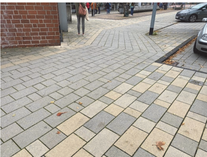
Bilder 34 und 35 | Priorisierung der Verkehrsarten: eine kritische Engstelle für den Fußverkehr (links im Foto, rechts im Ausführungsplan) ergibt sich durch Priorisierung der Anforderungen des ruhenden Kfz-Verkehrs und des Radverkehrs gegenüber dem Fußverkehr – durch Verzicht auf wenige Parkstände hätte dies vermieden werden können
