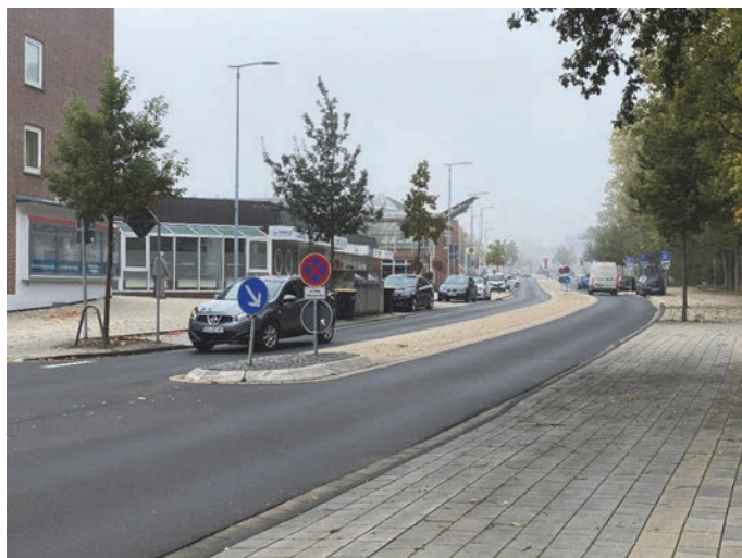
Bilder 15 und 16 | Nutzungs- und Gestaltungsdetails: Verkehrszeichen „Absolutes Haltverbot“ (StVO-Z. 283) mit Zusatz „Auf dem Mittelstreifen“ auf dem Fahrbahnteiler, der den Mittelstreifen einleitet (links), Sondersituation mit schmalerem Mittelstreifen ohne Überquerungsfunktion im Bereich der Brücke über die Bauna (rechts)
