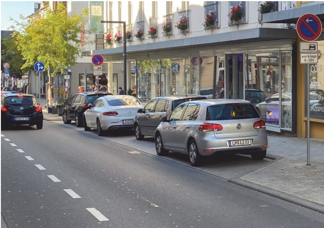
Bild 27 | Bautechnische Details: Ladezonenbucht auf Fahrbahnniveau gepflastert und mit Rundbordstein zum Seitenraum abgegrenzt, schmale wasserführende Gußasphaltrinne mit Straßenablauf
