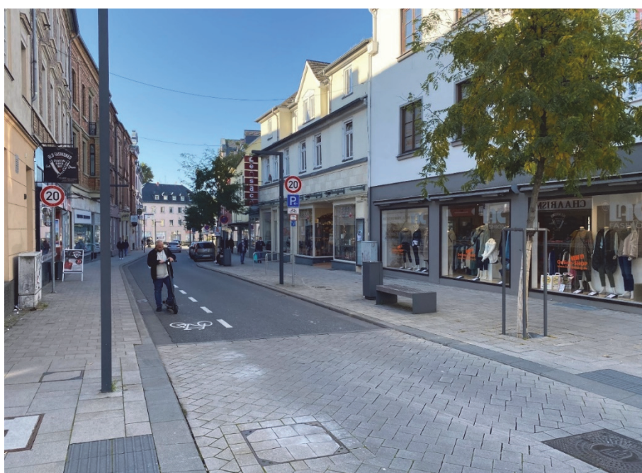
Bild 9 | Fahrbahn im Querschnitt: 3,00 m breiter Fahrstreifen in Einbahnrichtung mit über den gesamten umgestalteten Abschnitt markiertem, 1,25 m breitem Schutzstreifen zur Sicherung des Radverkehrs in Gegenrichtung, Beschränkung der Fahrgeschwindigkeit auf 20 km/h im gesamten Abschnitt
