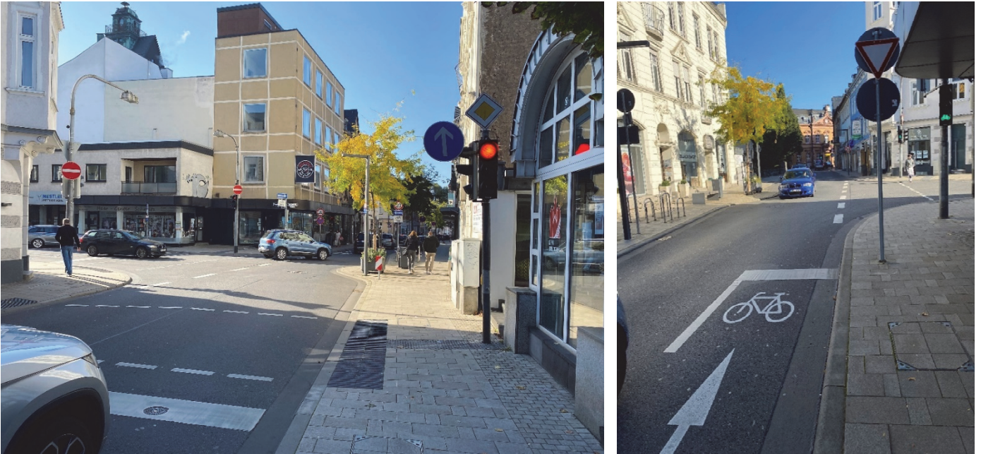
Bilder 12 und 13 | Signalisierung der östlichen Einmündung: signalisierte Furten für den Fußverkehr in der südlichen und östlichen Zufahrt (links), eigenes Signal für den Radverkehr entgegen der Einbahnstraße (rechts)
