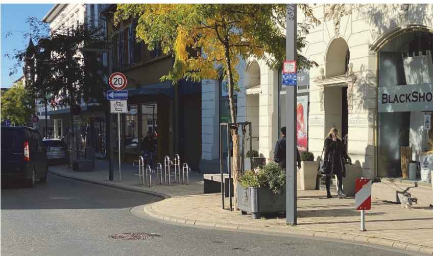
Bilder 14 und 15 | Östliche Einfahrt in den umgestalteten Abschnitt: deutliche Verschwenkung des Seitenraums im Einmündungsbereich zur Verlangsamung des einfahrenden Kfz-Verkehrs und Anpassung an die nachfolgende Geschwindigkeitsbeschränkung auf 20 km/h
