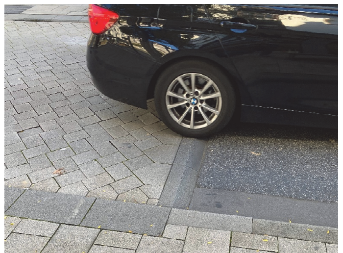
Bilder 25 und 26 | Bautechnische Details: nahezu auf Gehwegniveau angehobene Teilaufpflasterung mit Flachbordstein zur Asphaltfahrbahn hin, 2 cm-Kante zwischen Pflasterfläche und Gehweg auf nahezu gesamter Breite und Nullabsenkung für Rollstuhlfahrende in einem kurzen Teilbereich (in Bild 24 hinten sichtbar)
