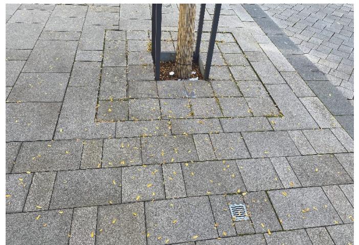
Bilder 28 und 29 | Bautechnische Details: überpflasterte Baumscheibe mit Belüftungskappen auf Unterflurbaumrost, links im Bau, rechts fertiggestellt
