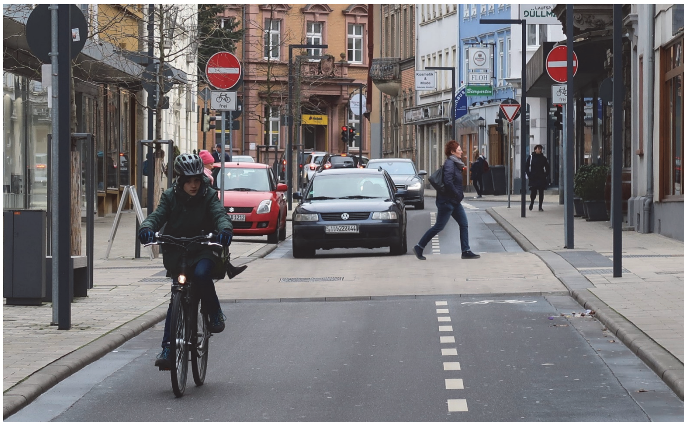
Bild 22 | Kreuzung von Grabenstraße und Bahnhofstraße: verstärkende fahrdynamische Wirkung der zentralen Teilaufpflasterung durch Aufnahme der Querneigung aus der Bahnhofstraße
