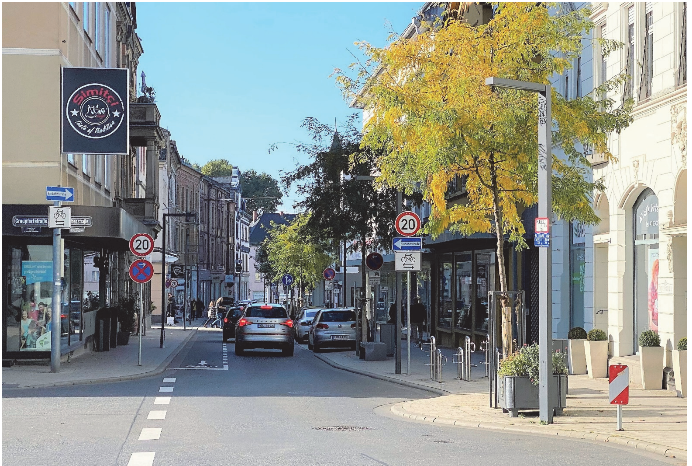
Bild 1 | Die Grabenstraße nach dem Umbau: Einbahnstraße mit Tempo 20-Regelung, Schutzstreifen für den Radverkehr in Gegenrichtung und durchweg verbreiterte Seitenräume mit Sitzgelegenheiten, Radabstellbügeln und Baumpflanzungen erhöhen Komfort und Verkehrssicherheit für Zufußgehende und Radfahrende und die straßenräumliche Attraktivität insgesamt
