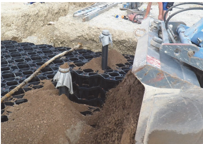
Bilder 28 und 29 | Bautechnische Details: überpflasterte Baumscheibe mit Belüftungskappen auf Unterflurbaumrost, links im Bau, rechts fertiggestellt
