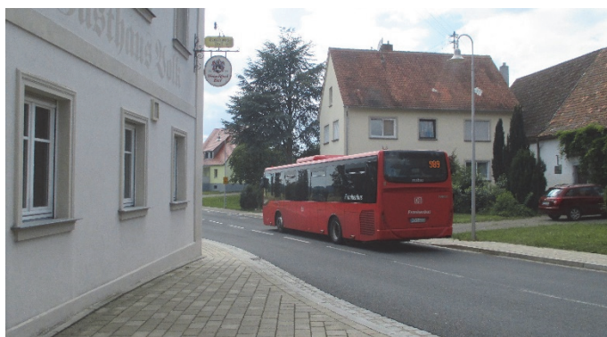
Bilder 19 bis 22 | Seitenraumgestaltung: nunmehr lückenlose Gehwege beiderseits der Fahrbahn (oben), Erweiterung der nutzbaren Gehwegbreite durch übergehbaren Wurzelbereich (unten links) oder Teilabbriss eines Gebäudes (oben rechts), nur punktuell (unten rechts) verbleiben Gehwegbreiten unter Mindestmaß nach Regelwerk – aber bei 1,25 m Restbreite bleibt die Passage auch z. B. für Rollator oder Rollstuhl Nutzende ohne Ausweichen auf die Fahrbahn möglich
