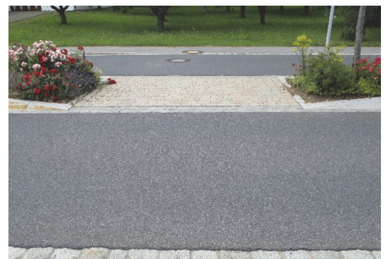
Bilder 11 bis 13 | Fahrbahnteiler mit Überquerungsfunktion: abgesenkte Bordsteine am Fahrbahnrand, niveaugleich zur Asphaltfahrbahn ausgelegte Standfläche in Fahrbahnmitte, ein- und ausleitende Pflasterflächen, kurze Baumreihen zur Fokussierung der Wahrnehmung von Weitem, Positionierung der Straßenlaternen aus Fahrtrichtung vor und des Mittenbaums hinter der Überquerungslinie
