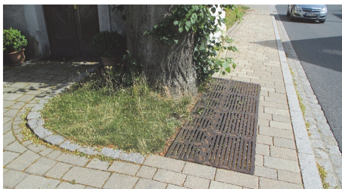
Bilder 19 bis 22 | Seitenraumgestaltung: nunmehr lückenlose Gehwege beiderseits der Fahrbahn (oben), Erweiterung der nutzbaren Gehwegbreite durch übergehbaren Wurzelbereich (unten links) oder Teilabbriss eines Gebäudes (oben rechts), nur punktuell (unten rechts) verbleiben Gehwegbreiten unter Mindestmaß nach Regelwerk – aber bei 1,25 m Restbreite bleibt die Passage auch z. B. für Rollator oder Rollstuhl Nutzende ohne Ausweichen auf die Fahrbahn möglich
