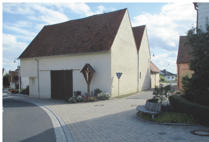
Bilder 23 bis 25 | Einmündungen: Pflasterflächen schaffen als „Gehwegüberfahrt“ zusammenhängende Gehwege, legen die Priorität von im Zuge der Ortsdurchfahrt Zufußgehenden gestalterisch nahe und stellen eine gestalterische Verbindung zu Nebenstraßen und -flächen her
