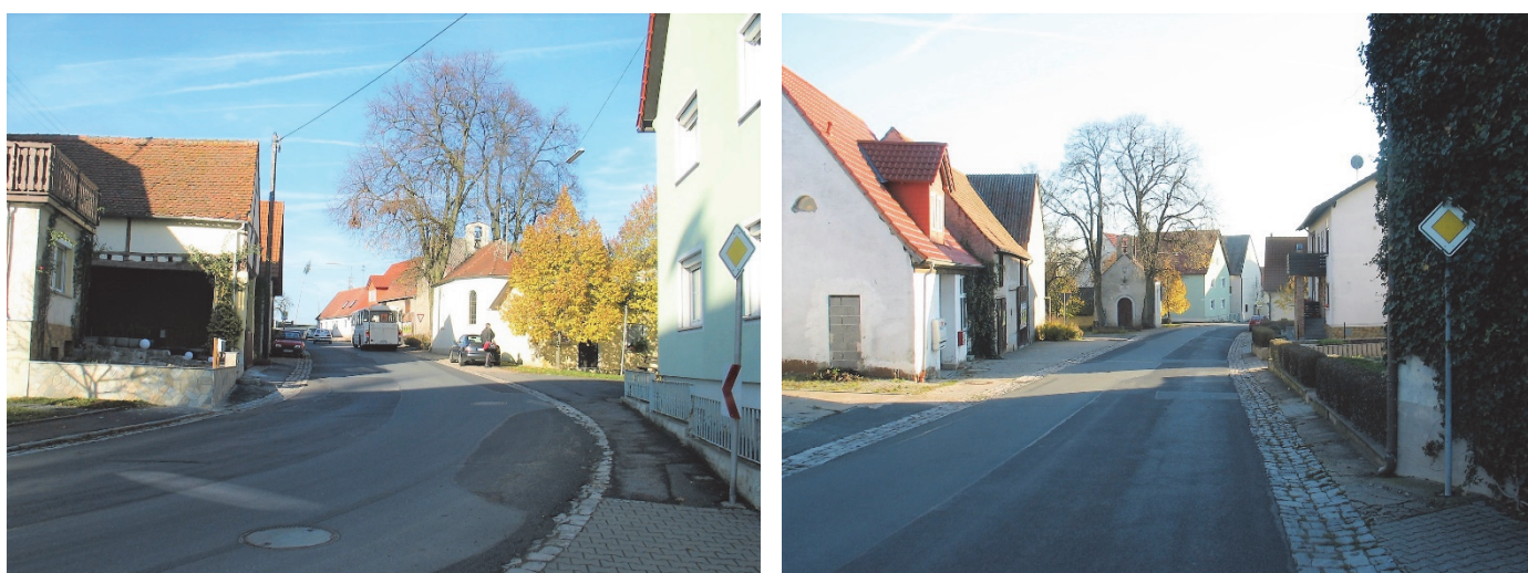
Bilder 3 und 4 | Vorher-Situation Ortsdurchfahrt: Die Fahrbahn dominiert den Straßenraum und lässt keinen Platz für Gehwege, der Zustand der Seitenräume ist sanierungsbedürftig
