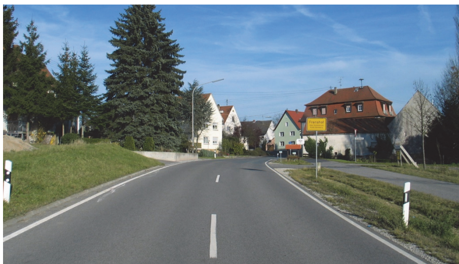
Bild 5 | Vorher-Situation Ortseinfahrt: Der Ortseingangsbereich ist gestalterisch undefiniert, der außerorts verlaufende einseitige kombinierte Geh- und Radweg mündet hinter der Ortstafel ungeschützt in die Fahrbahn
