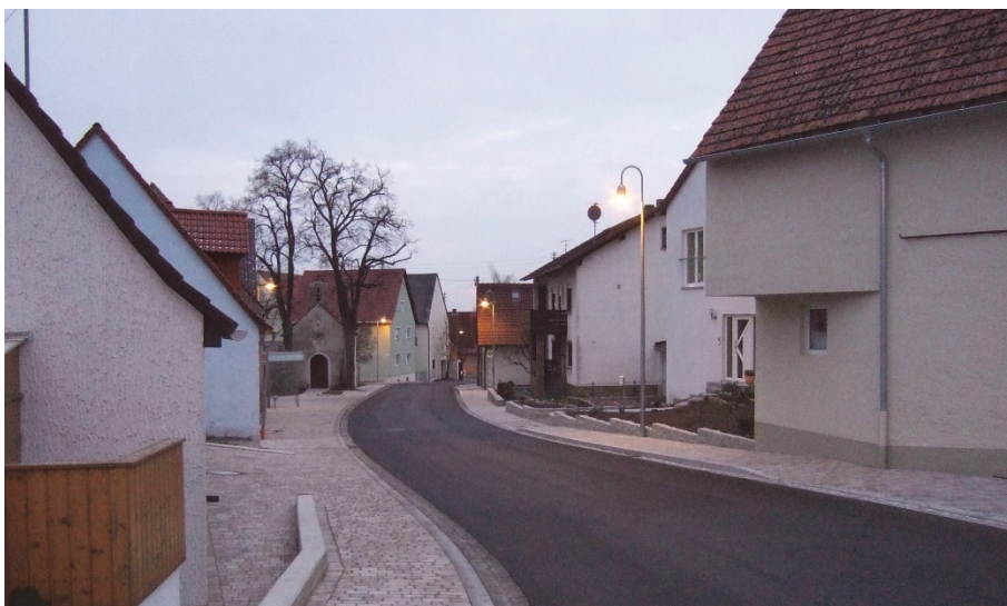
Bild 16 | Fahrbahngestaltung innerorts: schmale zweistreifige Asphaltfahrbahn mit zweizeiligen Bordrinnen und Hochbordstein (außer in Einmündungen und Grundstückszufahrten), die neue Beleuchtung dient vorrangig zur Ausleuchtung der Seitenräume und vermittelt stärker als die vorherigen fahrbahnmittig abgespannten Hängeleuchten die dörfliche Situation
