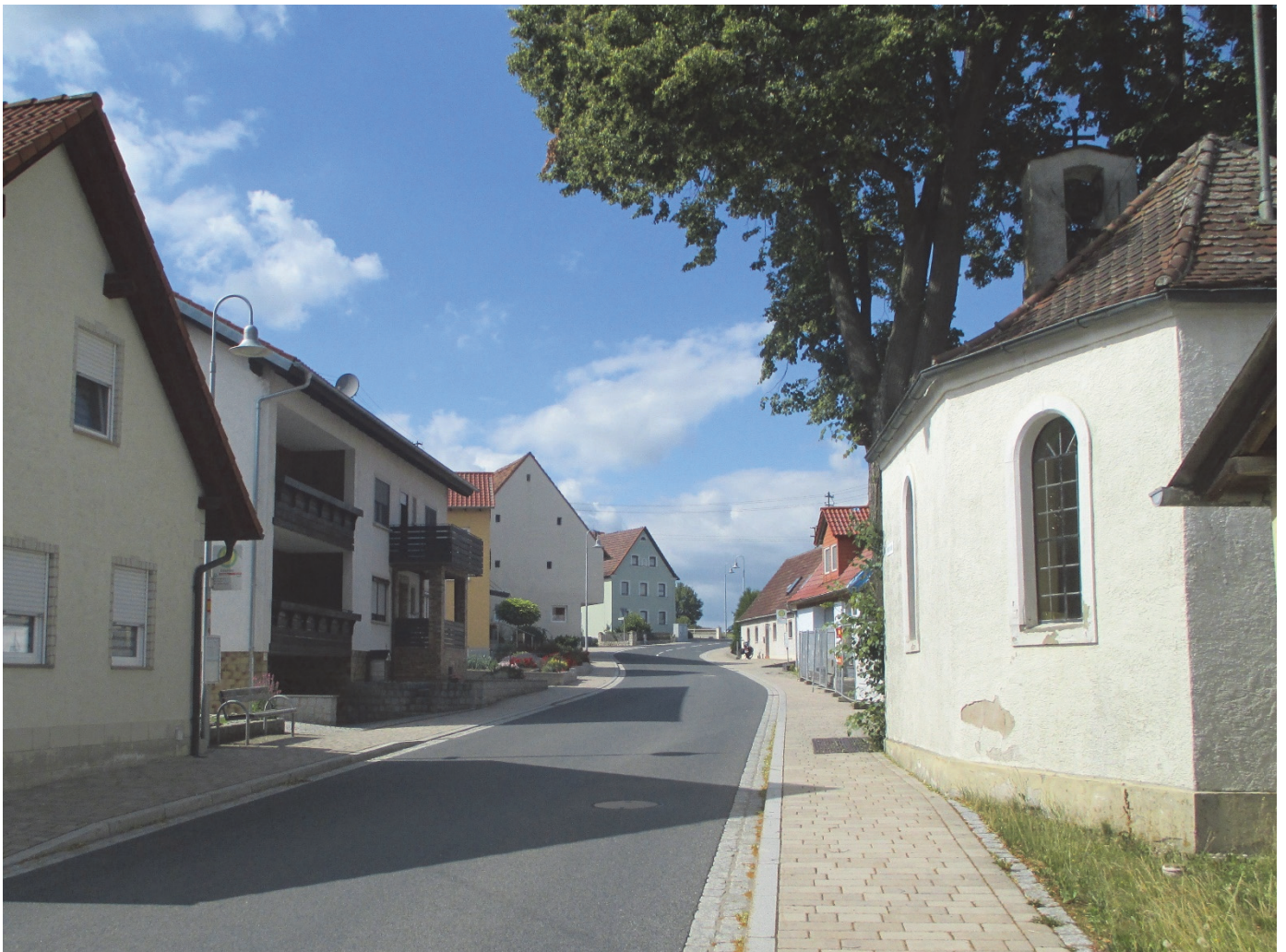
Bild 1 | Die Hauptstraße nach dem Umbau: dem Dorfgrundriss angepasste Linienführung, nunmehr lückenlose Gehwege überwiegend in Mindestbreite nach Regelwerk, Einbindung der Hausvorbereiche und Nebenstraßen in die Gestaltung
