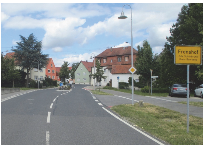
Bilder 9 und 10 | Ortseinfahrt: Verschwenkung des ortseinwärts gerichteten Fahrstreifens (siehe linkes Foto) zur Aufmerksamkeitserhöhung und Geschwindigkeitsreduzierung, Fahrbahnteiler mit Baum und niedriger Unterpflanzung zur Verortung des „Orts- eingangs“ und Überleitung in die Ortsdurchfahrt, der kurze Radfahrstreifen bringt Radfahrende sicher auf die Fahrbahn
