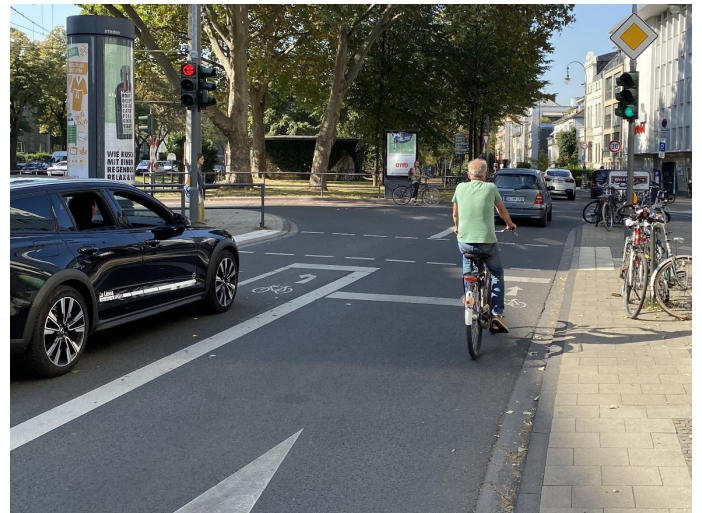
Bilder 24 bis 27 | Bestandswahrung als absolute Ausnahme: Um den Kfz-Linksabbiegefahrstreifen und die vorhandenen Baumreihe im angrenzenden Seitenraum beibehalten zu können, ist in einem kurzen Abschnitt des Karolingerringes der Schutzstreifen ausgesetzt; im Aufstellbereich vor der Lichtsignalanlage sind ein schmaler Streifen für links abbiegende und eine ebenso schmale Aufstellfläche für geradeaus Radfahrende, beide vorgezogen, markiert – eher symbolisch, da meist selbst von Pkw überfahren.
