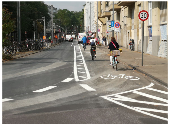
Bilder 15 bis 17 | Regellösung der Radverkehrsführung: 2,50 m breite Radfahrstreifen, im Normalfall durch eine doppelte Breitstrichmarkierung zum verbleibenden Kfz-Fahrstreifen der vormals zweistreifigen Richtungsfahrbahn hin abgegrenzt
