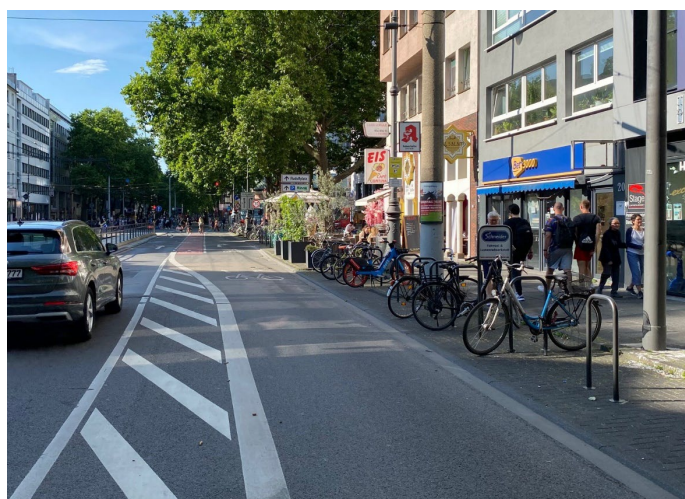
Bilder 42 bis 44 | Sonderlösung im Querschnitt: ausgehend von der Knotenpunktausfahrt sind Taxistände, Fahrradparken und Liefers/Laden in Fahrbahnmitte angeordnet, vormalige Längsparkstände am Fahrbahnrand wurden mit Bügeln zum Abstellen von Fahrrädern ausgestattet oder für außergastronomische Nutzungen freigegeben; aus der Sperrfläche wird im weiteren Straßenverlauf ein Schutzstreifen für geradeaus Radfahrende entwickelt (Bild unten rechts im Hintergrund)
