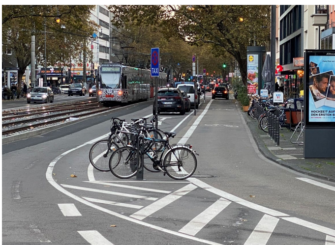
Bilder 42 bis 44 | Sonderlösung im Querschnitt: ausgehend von der Knotenpunktausfahrt sind Taxistände, Fahrradparken und Liefers/Laden in Fahrbahnmitte angeordnet, vormalige Längsparkstände am Fahrbahnrand wurden mit Bügeln zum Abstellen von Fahrrädern ausgestattet oder für außergastronomische Nutzungen freigegeben; aus der Sperrfläche wird im weiteren Straßenverlauf ein Schutzstreifen für geradeaus Radfahrende entwickelt (Bild unten rechts im Hintergrund)
