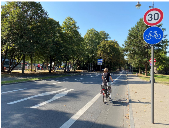
Bilder 15 bis 17 | Regellösung der Radverkehrsführung: 2,50 m breite Radfahrstreifen, im Normalfall durch eine doppelte Breitstrichmarkierung zum verbleibenden Kfz-Fahrstreifen der vormals zweistreifigen Richtungsfahrbahn hin abgegrenzt
