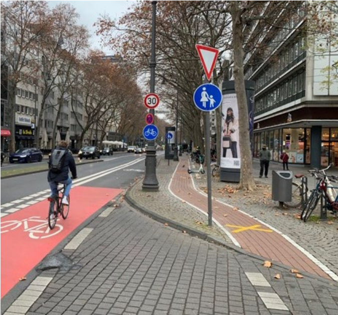
Bilder 51 und 52 | Provisorische Zwischenlösung: trotz gelber Abmarkierung des aufgehobenen Radwegs (links) bzw. gelber Fahrbahnmarkierung und hinweisender Beschilderung (rechts) benutzten viele Radfahrende anfangs weiter den schmalen Radweg
