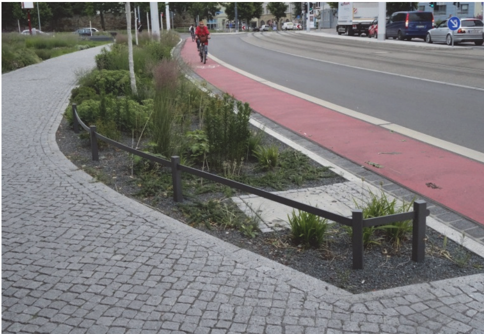
Bild 17 | Seitenraumgestaltung am Huttenplatz: Pflanzbeete dienen als Abgrenzung zur Fahrbahn und betonen gemeinsam mit dem einheitlich gepflasterten Gehbereich ohne Gehbahn die Platzfunktion
