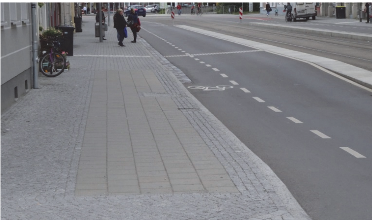
Bild 16 | Differenzierung des Seitenraums: Ober- und Unterbahn aus Natursteinpflaster sowie Gehbahn aus Betonplatten definieren Gehweg, Aufenthalts- und Sicherheitsstreifen
