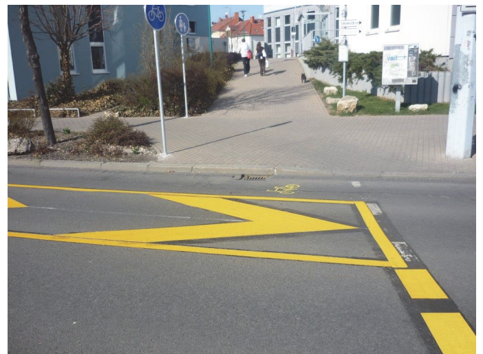
Bilder 18 und 19 | Provisorische Umgestaltung: Sperrflächenmarkierungen, Fahrstreifen mit Fahrradsymbol etc. ermöglichen vorwegnehmende Erfahrungen mit neuen Gestaltungs- und Führungselementen
