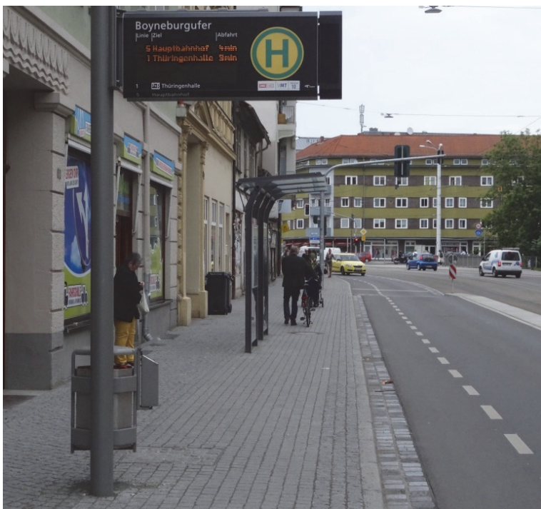
Bild 13 | Wartefläche im Seitenraum: dezente Differenzierung von Geh- und Wartefläche durch unterschiedliche Verlegart des Natursteinpflasters sowie transparenter Unterstand, der als attraktives Gestaltungselement zugleich mehr soziale Sicherheit für wartende Fahrgäste bietet
