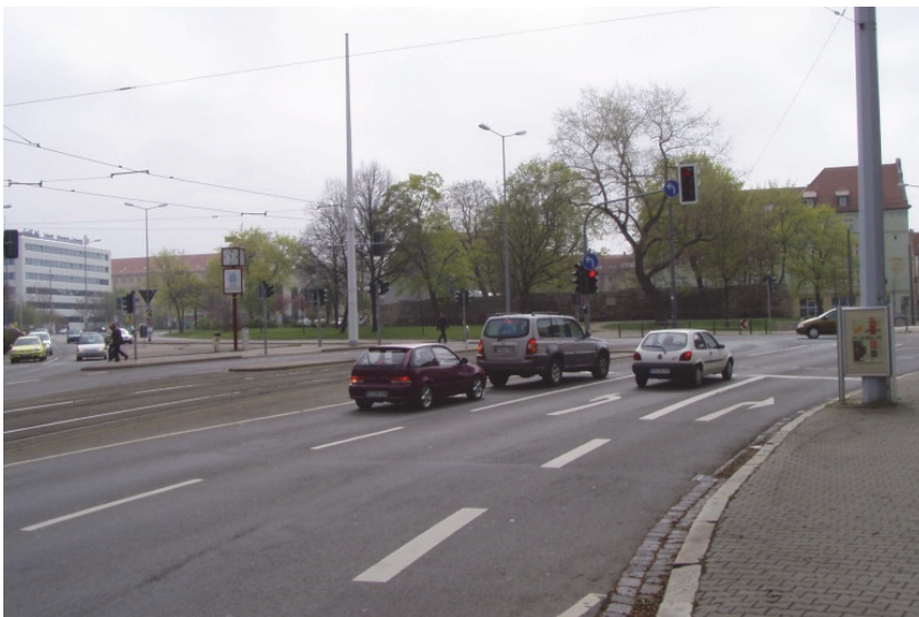
Bild 4 | Vorher-Situation: Überdimensionierte Verkehrsflächen für den Kfz-Verkehr im Knotenpunkt und auf der Strecke
