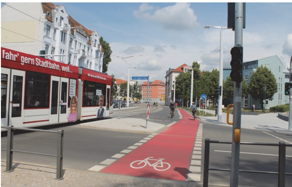
Bild 18 | Radverkehrsführung im Knotenpunkt: durchgängig rot eingefärbte Radfahrstreifen schaffen Sicherheit und Orientierung für Radfahrenden und eine gute Sichtbarkeit der Anlage für Kraftfahrende
