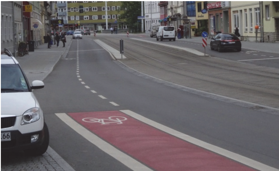
Bild 19 | Radverkehrsführung neben Parkstreifen: rot eingefärbter Radfahrstreifen mit ausreichend breiten Sicherheitsstreifen zu den parkenden Fahrzeugen hin
