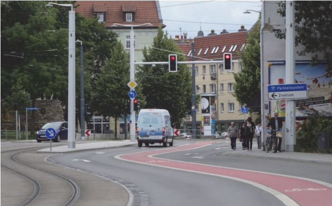
Bilder 14 und 15 | Verkehrsflächenaufteilung: deutliche Kennzeichnung und Eingrenzung der verschiedenen Verkehrsflächen für Stadtbahn, Kraftfahrzeugverkehr, Radverkehr und Fußverkehr durch Markierungen, Borde und unterschiedlichen Oberflächenbelag – in den Knotenpunkten zusätzlich unterstützt durch Fahrbahnteiler
