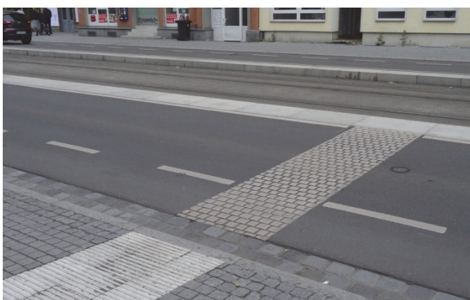
Bilder 10 bis 12 | Niederflergerecht und barrierefrei gestaltete Stadtbahnhaltestelle: breite, farblich deutlich wahrnehmbare Haltestellenborde als Ein- und Ausstiegshilfe neben angehobener Richtungsfahrbahn mit Schutzstreifen für Radfahrende sowie Leitindikatoren für sehbeeinträchtigte Fahrgäste (Prägung im Asphalt und helle Einfärbung) quer über die Fahrbahn hinweg
