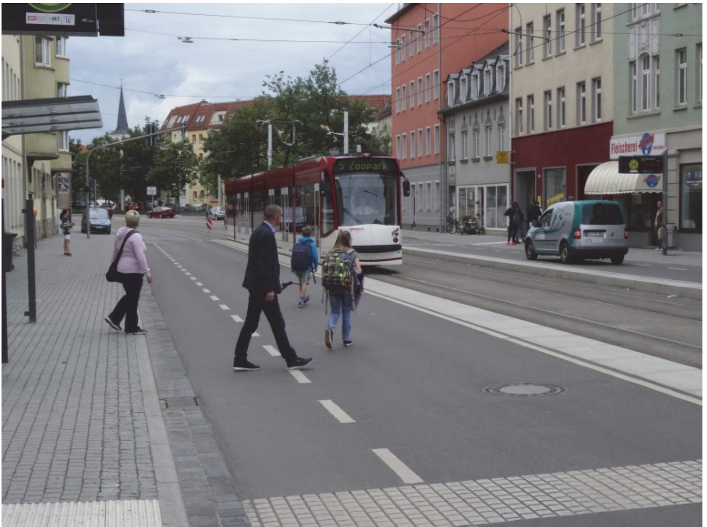
Bild 1 | Die Johannesstraße nach dem Umbau: Gliederung des Fahrbahnquerschnitts, Umgestaltung der Straßenbahnhaltestelle, mehr Raum für Zufußgehen, Verbesserung der Aufenthaltsqualität
