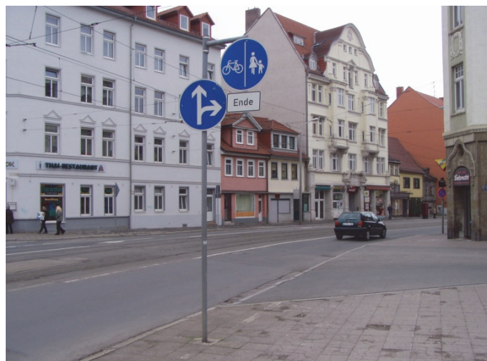
Bilder 5 bis 6 | Vorher-Situation: kein barrierefreier Zugang zu den Niederflurfahrzeugen der Stadtbahn in der Haltestelle, keine durchgehenden Radverkehrsanlagen
