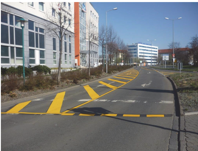
Bilder 18 und 19 | Provisorische Umgestaltung: Sperrflächenmarkierungen, Fahrstreifen mit Fahrradsymbol etc. ermöglichen vorwegnehmende Erfahrungen mit neuen Gestaltungs- und Führungselementen
