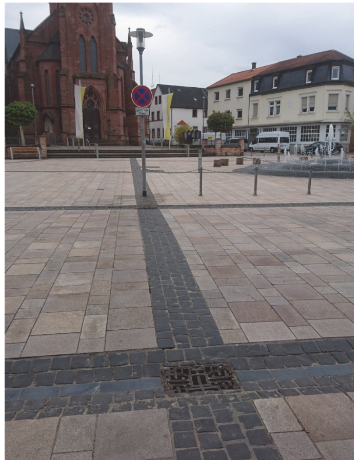
Bilder 16 und 17 | Gestaltungsdetail Pflasterbänder: fünfzeilige Muldenrinne als Begrenzungslinie zwischen Fahrgasse und Geh- bzw. Platzfläche mit mittiger Steinreihe als Widerlager für die beiden unterschiedlichen Teilflächen der Fahrgasse und des Platzes (Bild links), vierzeiliges Pflasterband ohne Entwässerungsfunktion als Fahrgasse und Platzfläche gliederndes und gleichzeitig orientierendes, die Wahrnehmung strukturierendes Element mit Verweis auf Kirchenportal, Springbrunnenanlage etc., Kreuzungspunkte sind durch Aufsatzleuchten zusätzlich vertikal hervorgehoben (Bild rechts)
