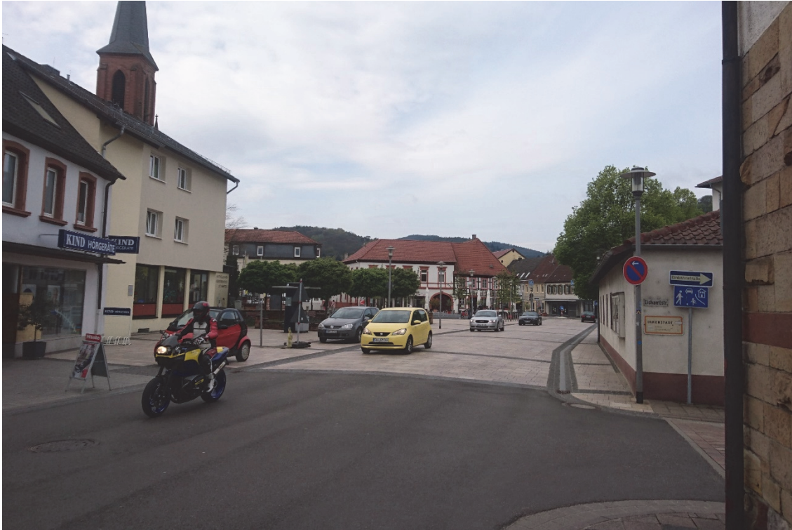
Bild 10 | Einfahrsituation aus Richtung Osten: Wechsel von der Asphaltfahrbahn zu einer durch Muldenrinnen begrenzten Fahrgasse in hellem Natursteinbelag öffnet gleichzeitig den Blick der Verkehrsteilnehmenden auf die aufgeweitete Platzfläche
