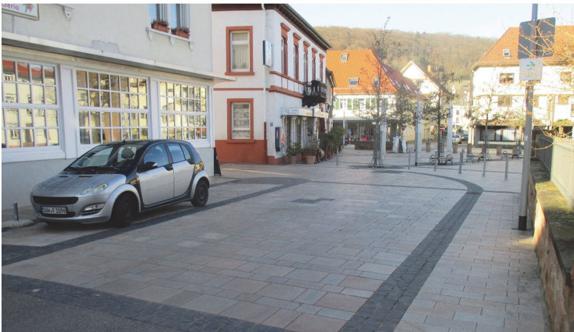
Bild 24 | Integrierte Fahrgasse: Erschließungsstraßen Georg-Weber-Straße und Schlittstraße bleiben durchgängig befahrbar, sind nun aber gestalterisch in den Platz integriert
