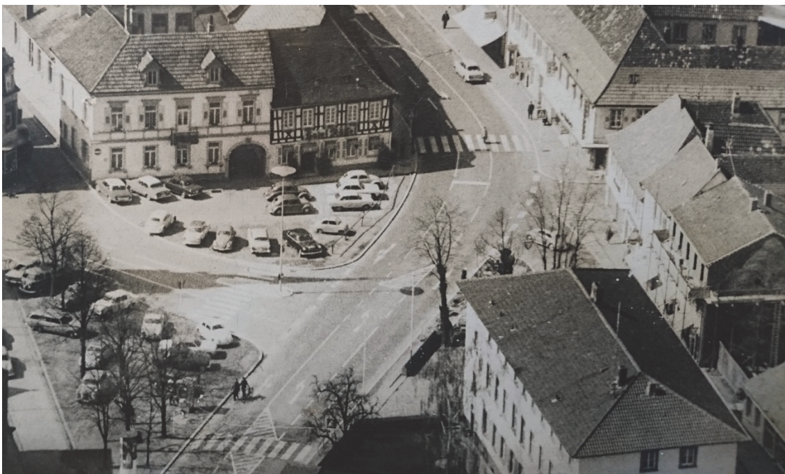
Bild 3 | Vorher-Situation: vier Straßen mit drei unmittelbar aufeinander folgenden Einmündungen in die hier dreistreifige Weinstraße (B 427) und zwei Parkplätze dominieren seit den 1960er Jahren den Ludwigsplatz und lassen keinen Raum für Aufenthaltsfunktionen und sicheres Zufußgehen
