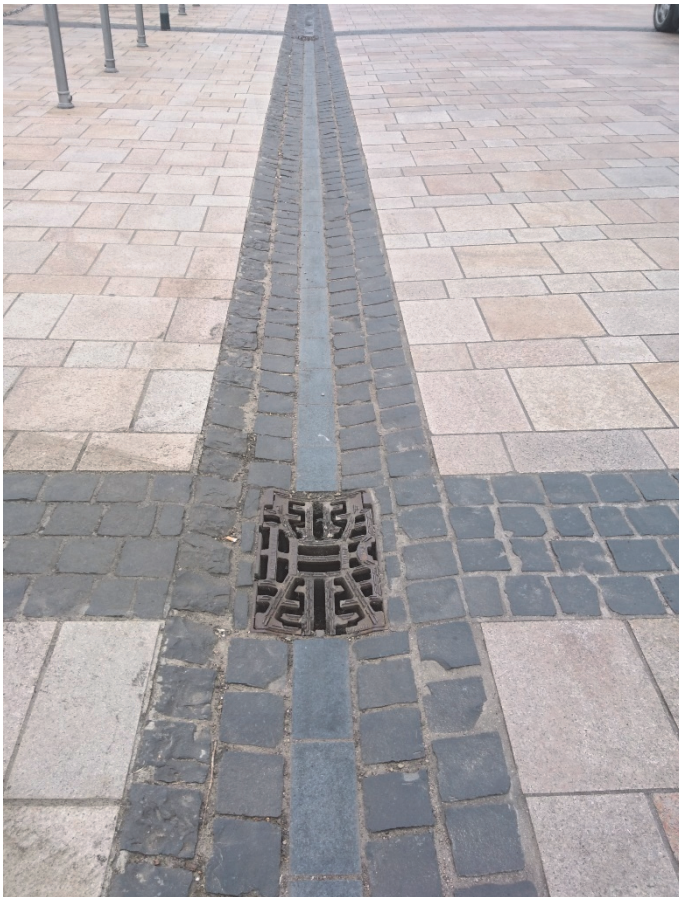
Bilder 16 und 17 | Gestaltungsdetail Pflasterbänder: fünfzeilige Muldenrinne als Begrenzungslinie zwischen Fahrgasse und Geh- bzw. Platzfläche mit mittiger Steinreihe als Widerlager für die beiden unterschiedlichen Teilflächen der Fahrgasse und des Platzes (Bild links), vierzeiliges Pflasterband ohne Entwässerungsfunktion als Fahrgasse und Platzfläche gliederndes und gleichzeitig orientierendes, die Wahrnehmung strukturierendes Element mit Verweis auf Kirchenportal, Springbrunnenanlage etc., Kreuzungspunkte sind durch Aufsatzleuchten zusätzlich vertikal hervorgehoben (Bild rechts)
