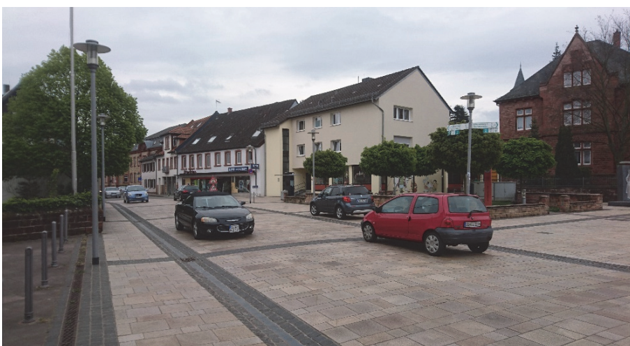
Bilder 12 und 13 | Ortsdurchfahrt der Bundesstraße als integrierter Bestandteil der Platzfläche: klar orientierte und zugleich visuell begrenzte Fahrgasse aus Sicht des Fahrzeugverkehrs
