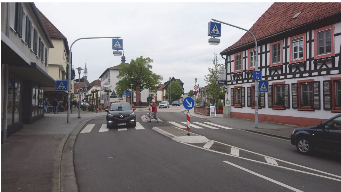
Bild 11 | Einfahrsituation aus Richtung Westen: der Kurve der Ortsdurchfahrt zum Ludwigplatz hin wird durch den vorgelagerten Fußgängerüberweg mit neu angelegter Mittelinsel gesichert und entschärft, nachfolgend gilt 30 km/h –man beachte die beidseitige direkte Zusatzbeleuchtung der „Zebrastrifen“-Markierung unter den nachts beleuchteten Schildern am Bogenmast
