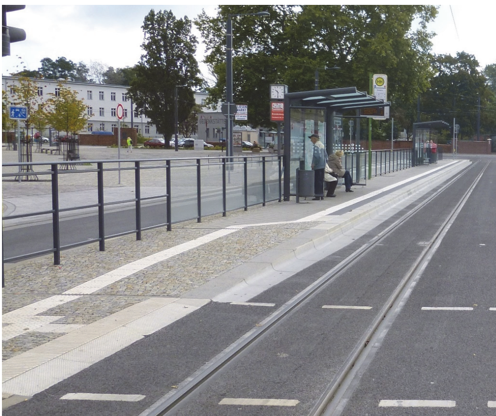
Bilder 19 und 20 | Bahnsteig und Zugang von der Fußgängerfurt aus: Elemente zur Unterstützung eines barrierefreien Zugangs
