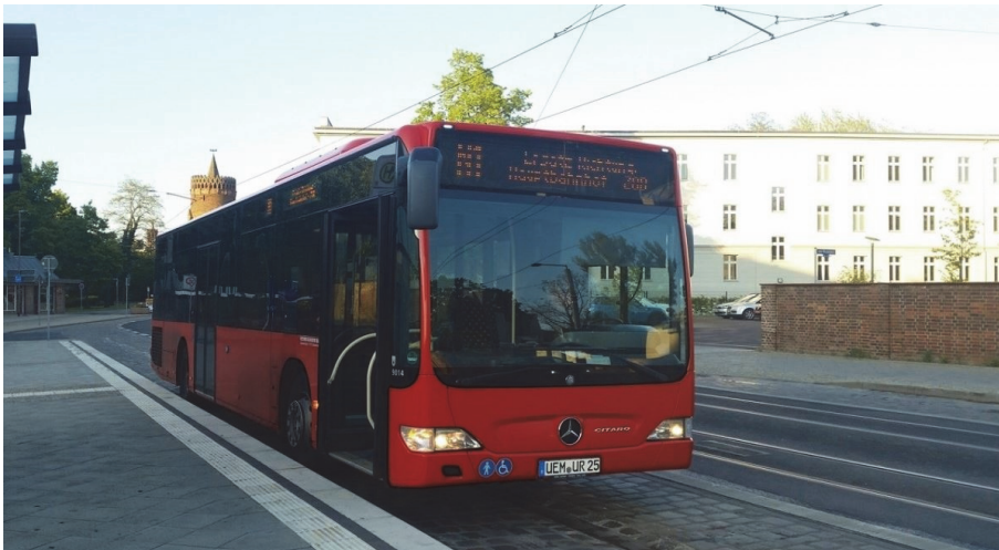
Bild 21 | Busbuchten und Warteflächen in der südöstlichen Fahrbahn (mit Blick zur Plauer Straße): kurze Umsteigebeziehungen durch hintereinanderliegende Haltepositionen, kontrastreiche Haltekante, mittig der Bucht verlaufende Entwässerungsrinne
