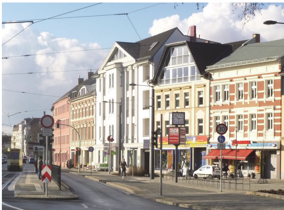
Bild 25 | StVO-Regelung für Radfahrende: die Geschwindigkeitsbeschränkung auf 30 km/h erlaubt grundsätzlich Radfahren im Mischverkehr auf der Fahrbahn, die 3,45 m breite Gehbahn (neben jeweils 60 cm breiten zusätzlichen Pflasterstreifen) ist zusätzlich für Radfahrer freigegeben
