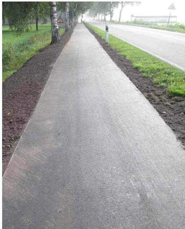
Gut investiertes Geld: Sanierung eines Radweges an einer Kreisstraße (Foto: Landkreis Osterholz)
