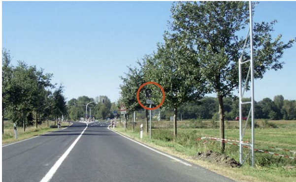
Bild 5: Beschilderung ist aufgrund der Bepflanzung nicht erkennbar, Abstand zwischen Fahrbahnrand und Bäumen ist zu gering
