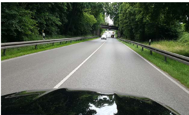
Hindernisfreie Seitenräume haben für Verantwortliche im Straßenbau und der Versicherungswirtschaft für die Verkehrssicherheit auf Landstraßen erhebliche Bedeutung. Foto: Rohrbach
