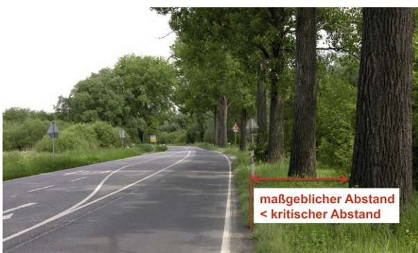
Bild 1: Abstand zwischen Fahrbahnrand und bestehenden Bäumen ist zu gering
