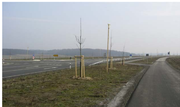
Bild 3: Fehlende Schutzeinrichtung vor neuer Bepflanzung, die Schutzeinrichtung müsste verlängert werden
