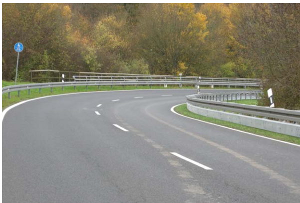
Unterfahrschutz auf der falschen Seite Foto: Biker Union e.V.
