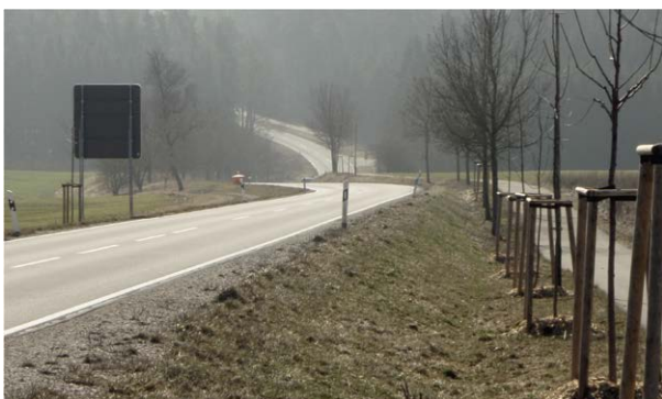
Bild 2: Abstand zwischen Fahrbahnrand und neu gepflanzten Bäumen ist zu gering
